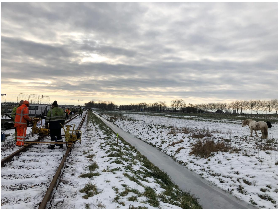
10 januari: een harde noord-oosten wind en temperaturen onder 0. Men kan zich de werkomstandigheden wel indenken!
