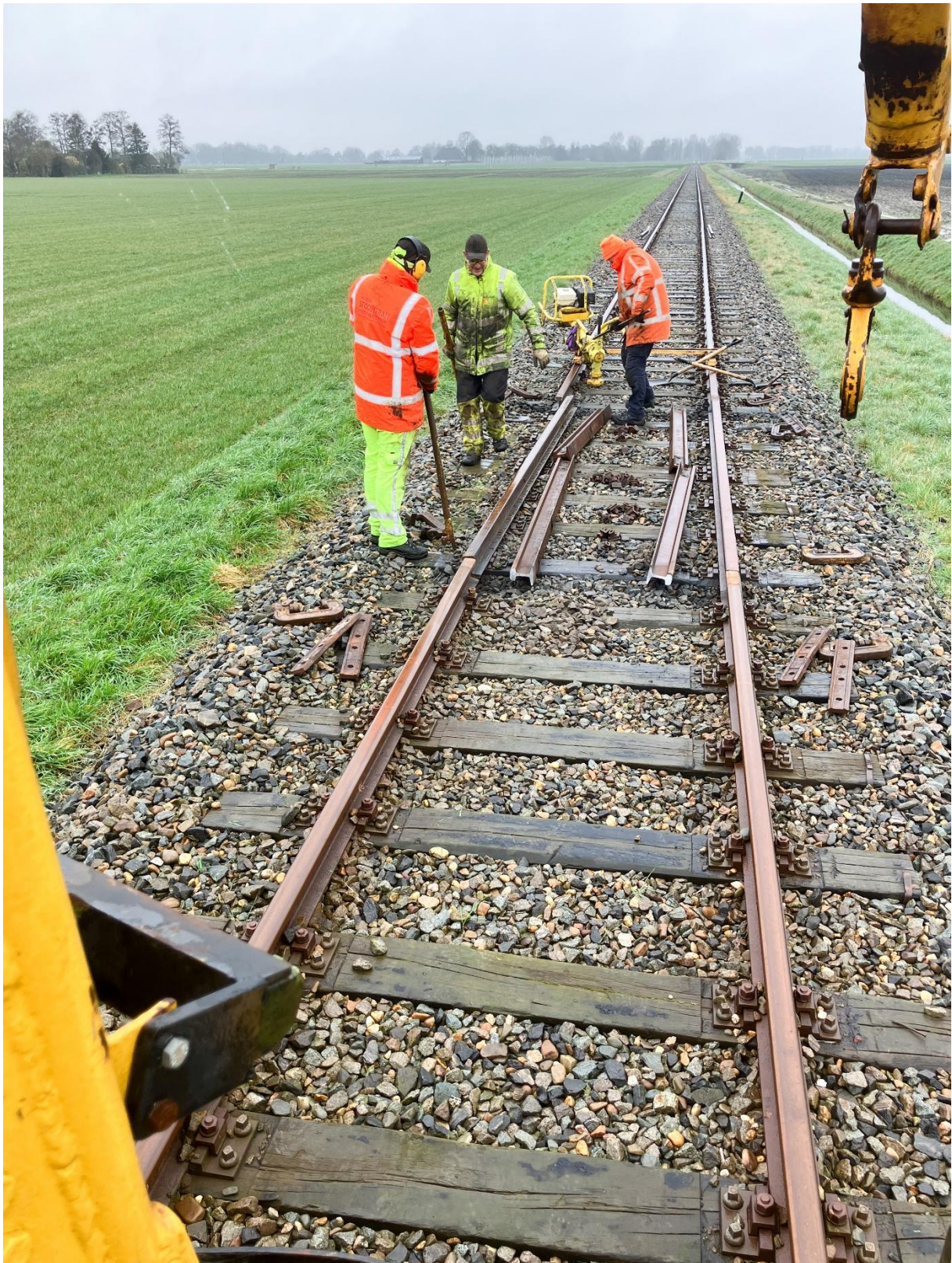
Hier zien we de beide afgezaagde uiteinden van de linker en rechter spoorstaaf in het midden liggen. Rechts is het gat al gevuld en links wordt de nieuwe spoorstaaf juist op z'n plaats gemanoeuvreerd.
