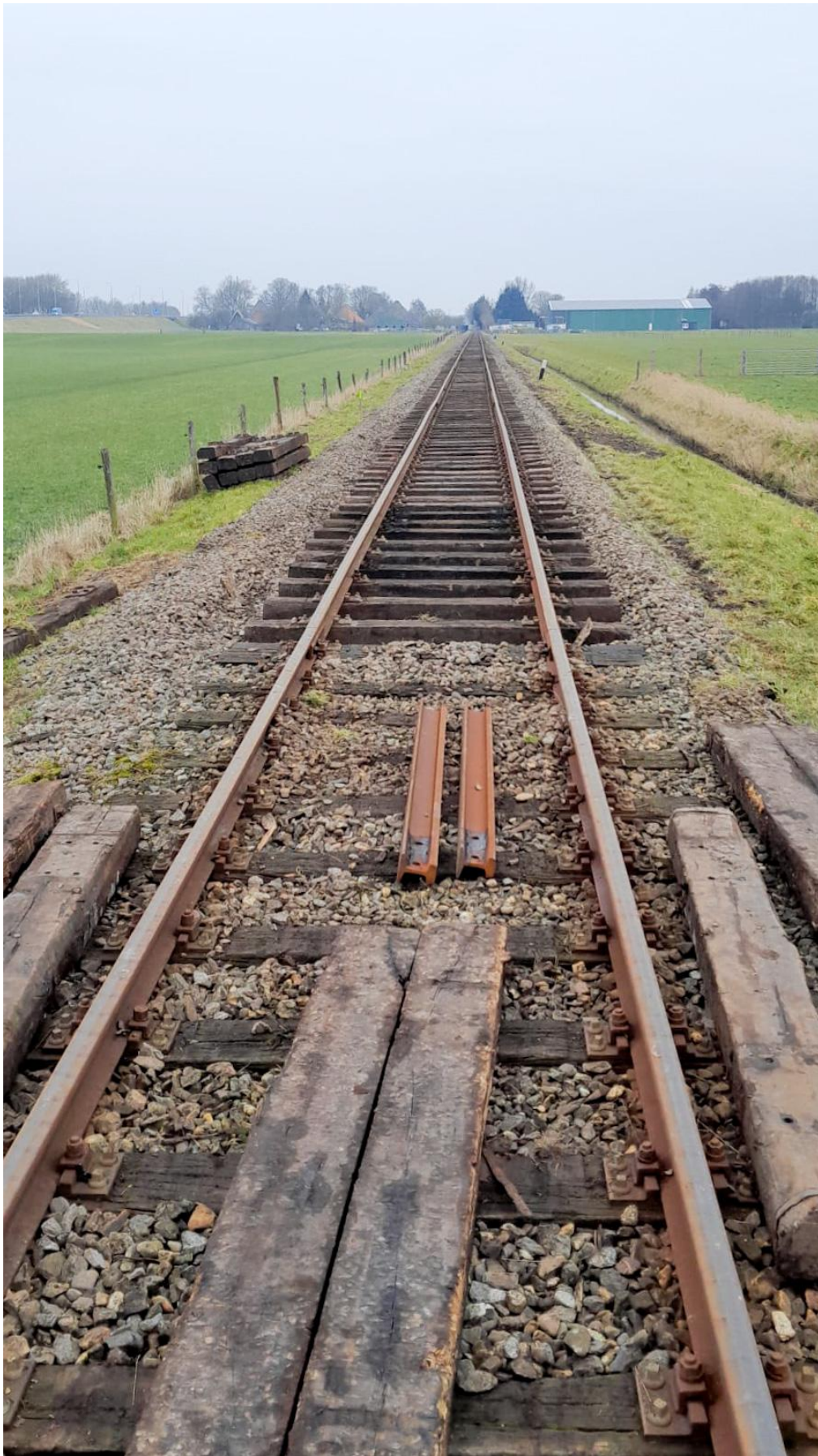
10 februari: alles zit weer aan elkaar vast en het gat in de spoorlijn is gesloten.
