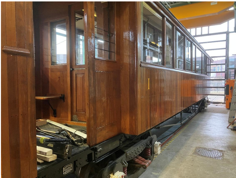
23 januari 2025: en ook op spoor 4 staat rijtuig ZVTM 8 een grondige lakbeurt te ondergaan.
