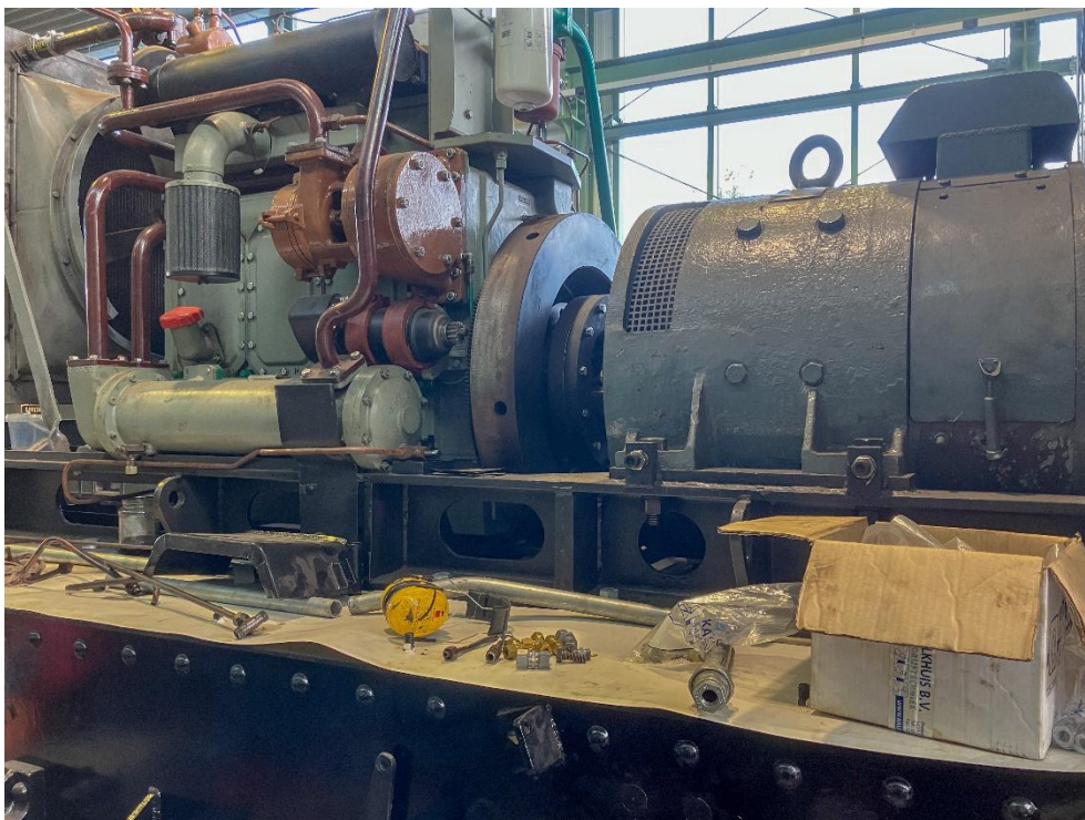
De gereviseerde motor en generator van NS 'sik' 271. Van de gelegenheid wordt meteen gebruik gemaakt om bijna alle kabels en leidingen te vernieuwen.
