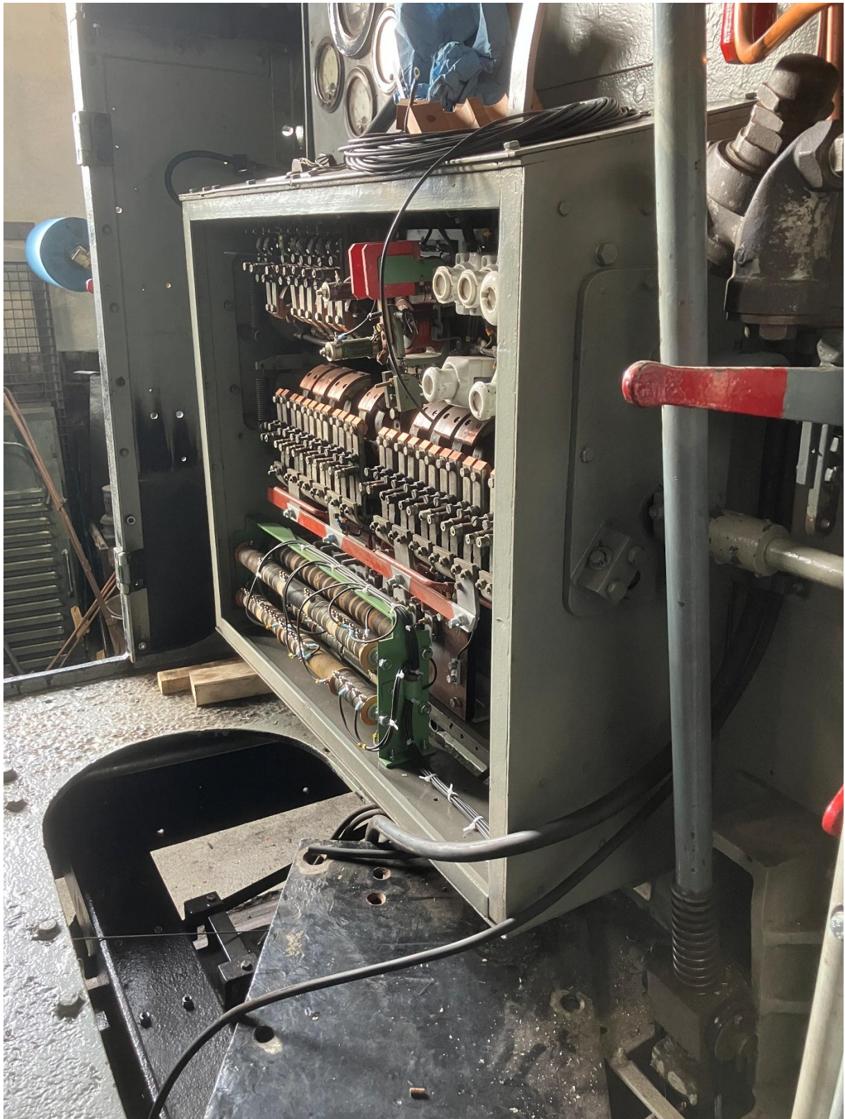
Op spoor 1 zagen we locomotor 271 al staan. Het schilderwerk vordert en de remleidingen worden aangepast aan een verbeterde constructie. De schakelkast is volledig gereviseerd.
