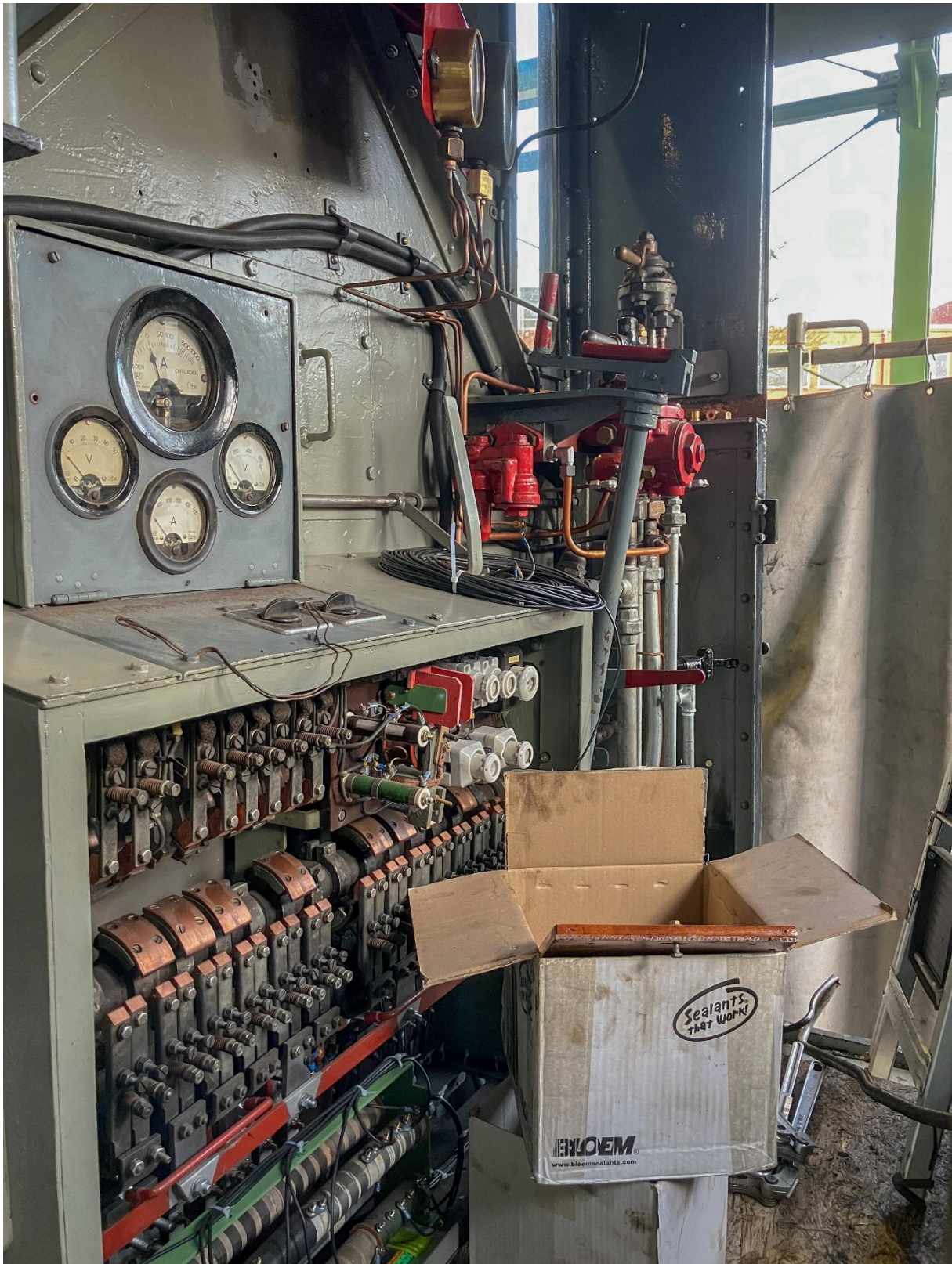
13 maart 2025: een kijkje in het machinistenhuis van locomotor 271; we zien de gereviseerde schakelkast en de nieuwe luchtrenkranen en -leidingen.
