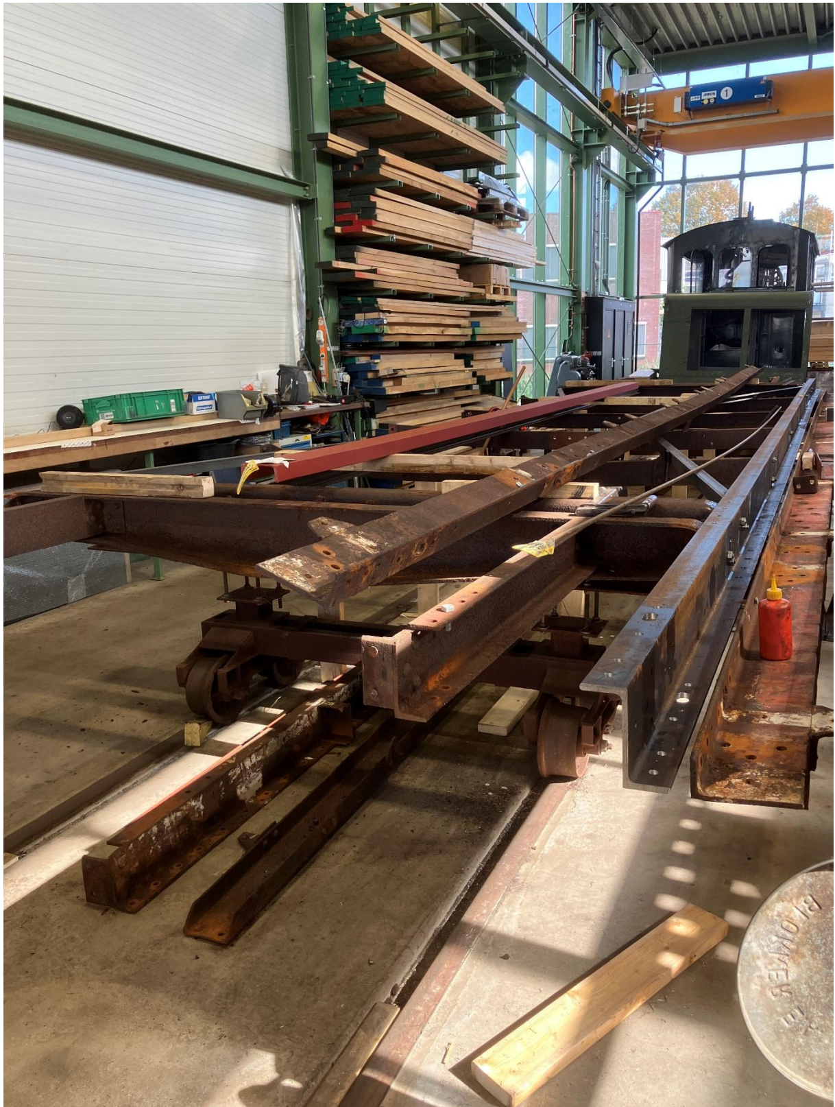
Verstevigingswerkzaamheden aan het onderstel van Bello-rijtuig 425.
