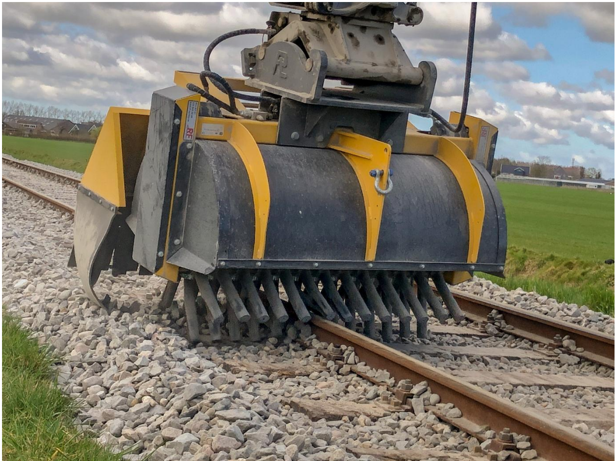
Dat gebeurt met een speciale borstel, gemonteerd op de kraan van onze aannemer Koning.
