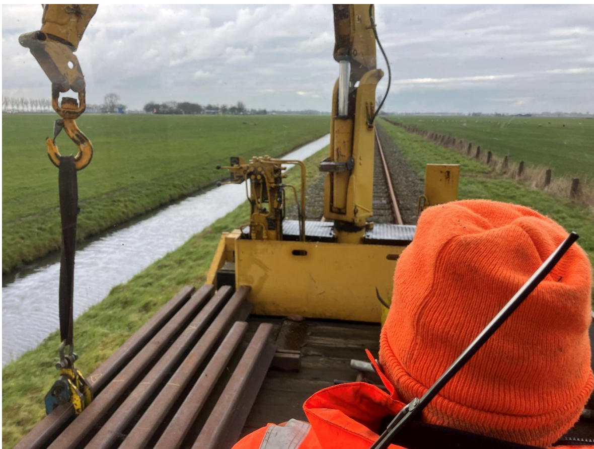
Ook op 23 januari ging de kraanvogel op pad om nabij de Poelweg (tussen Oostwoud en Twisk) enkele korte spoorstaven te lossen.
