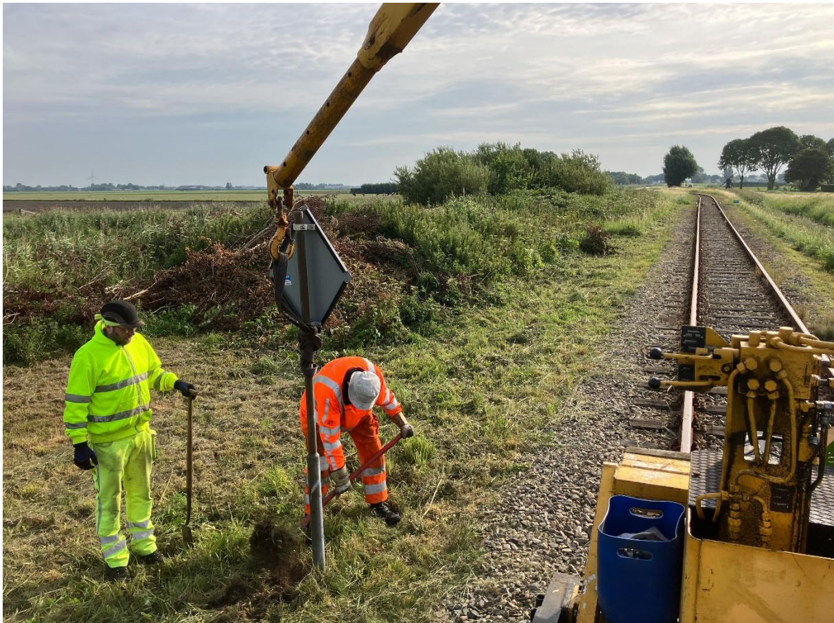
7 augustus 2025: de F-borden bij de overweg Broerdijk 2 worden vervangen door de veel robuuster versie, zoals die op 10 juli j.l. nog te zien was in Atelier Van der Molen.
