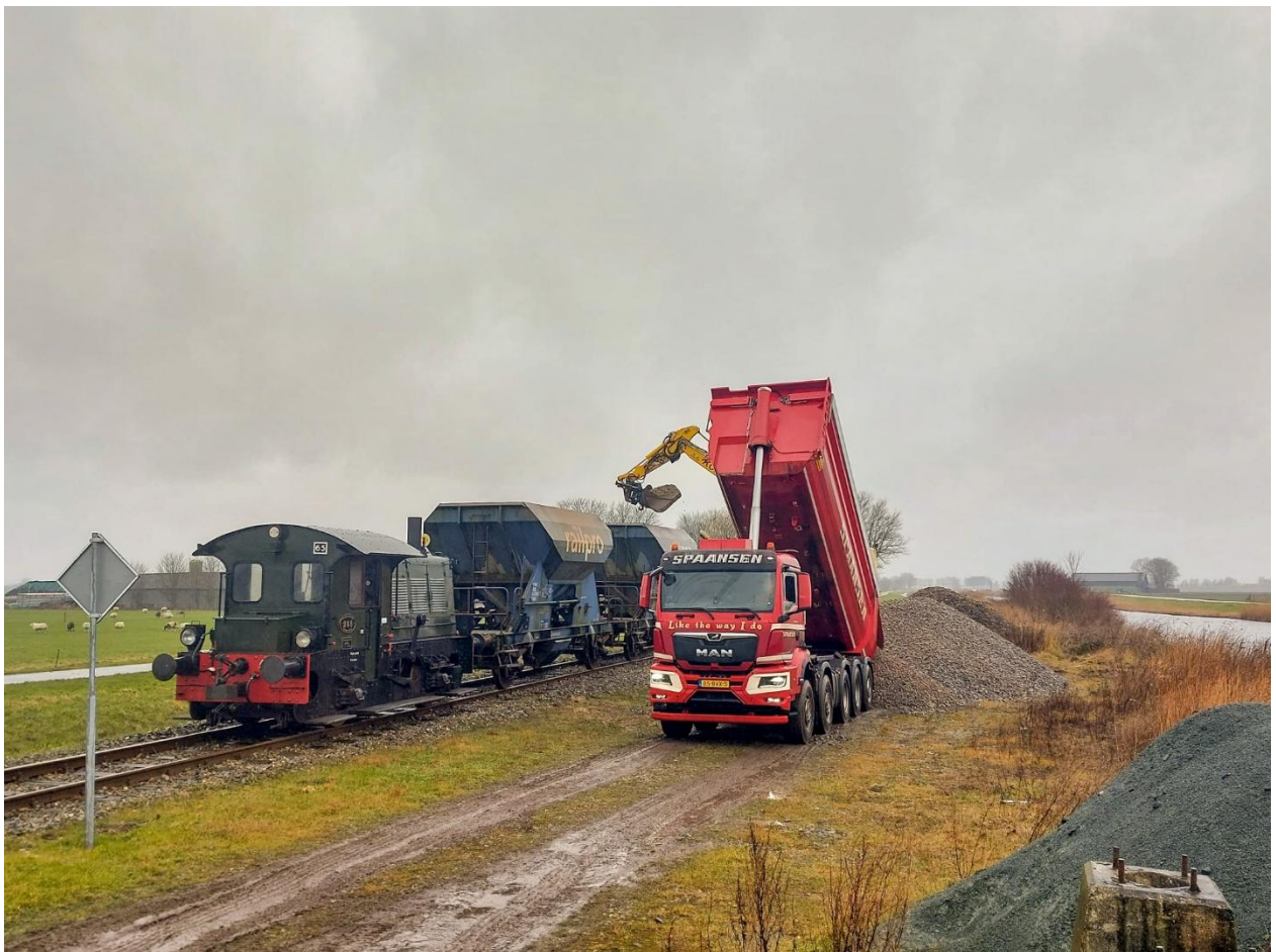
24 februari 2025: langs de Broerdijk wordt verse ballast geladen ten behoeve van het nieuw gelegde spoor tussen Zwaagdijk en Wognum.
