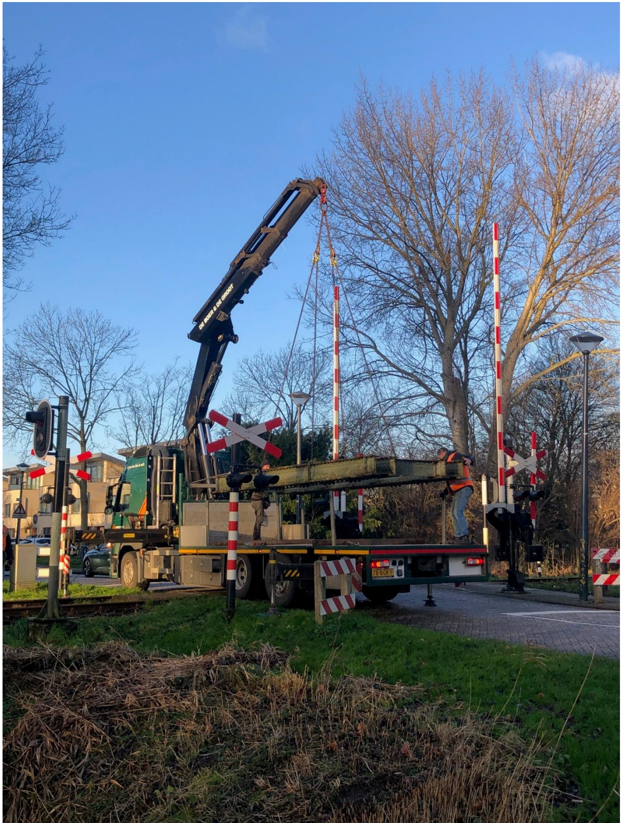
De brug wordt per vrachtwagen overgebracht naar een gespecialiseerd bedrijf in Friesland.
