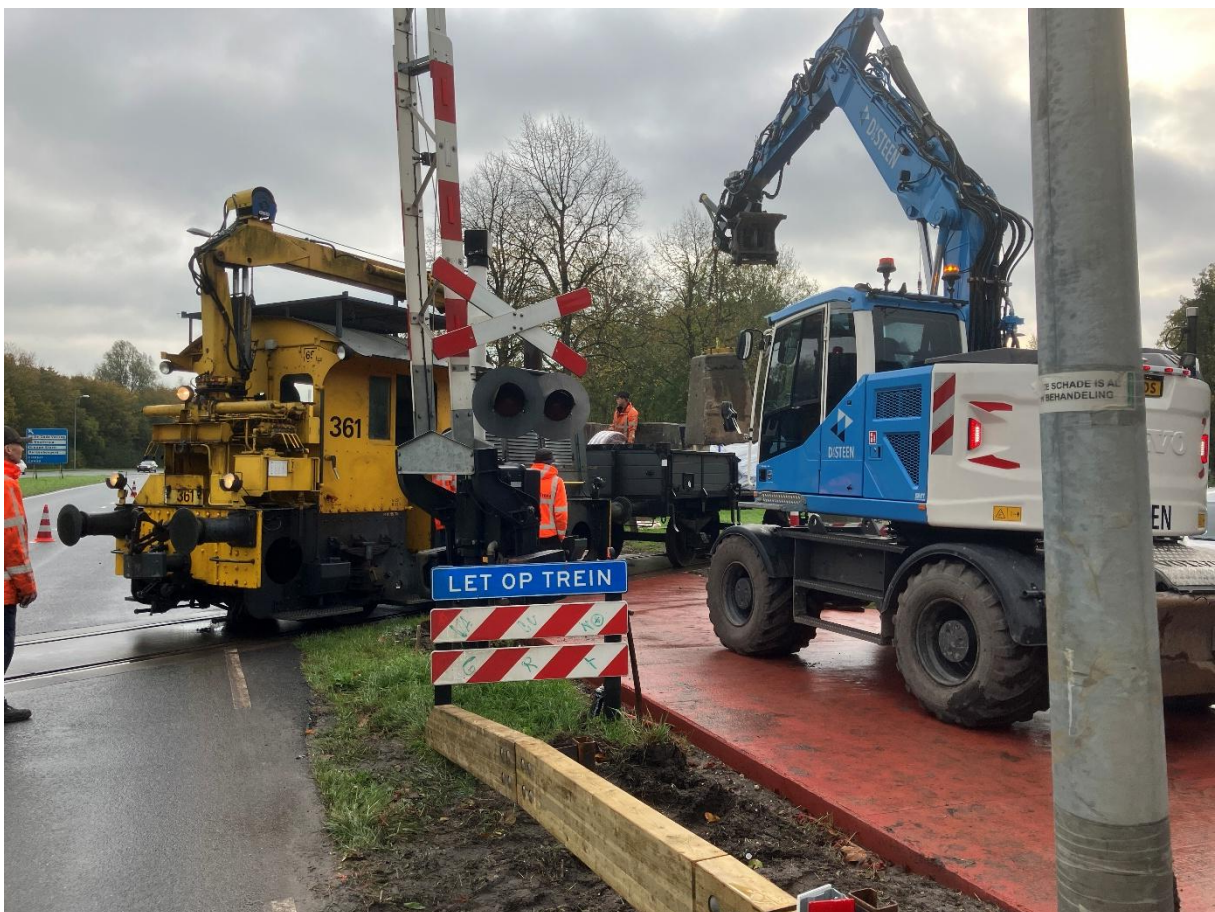
29 oktober 2025: bij de overweg Provinciale Weg in Hoorn worden mastvoeten aangevoerd t.b.v. nieuw te plaatsen afsluitbomen voor het fietspad.
