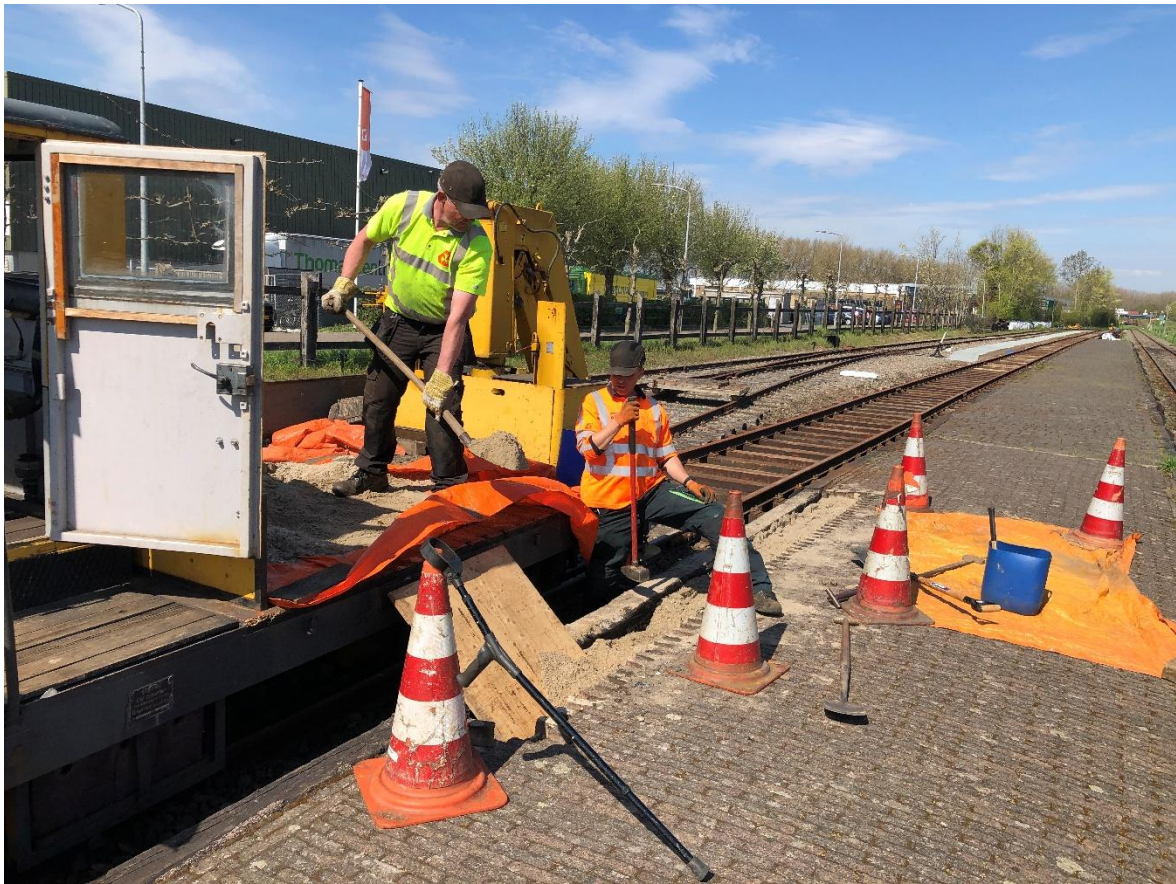
15 april 2025: het winterprogramma is min of meer afgerond, reparaties en onderhoud gaan gewoon door. In Wn wordt de perronwand hersteld.
