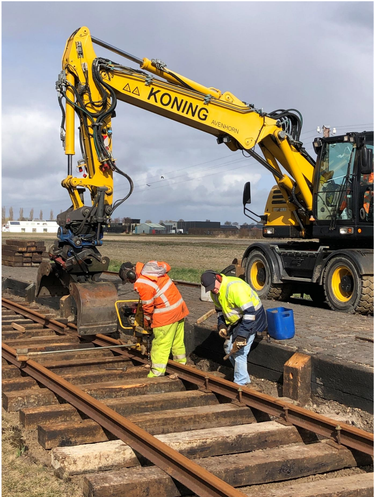
11 maart 2025: Wilco boort de gaten, Gert zet de kraagbouten erin, Roelof draait ze vast en Peter let vanuit de kraan op of het allemaal goed gaat. En last but not least: Matthé zorgt voor de koffie en algehele ondersteuning.
