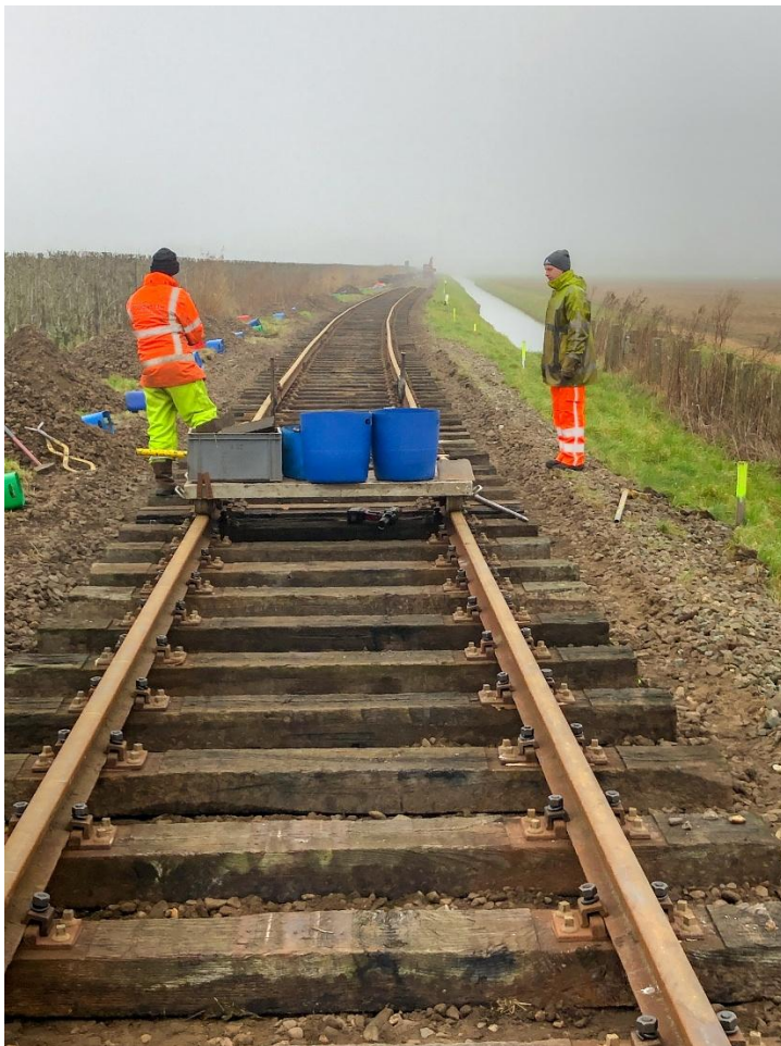
21 januari 2025: de eerste 60 meter is nieuw gelegd, geregeld en bebout.
