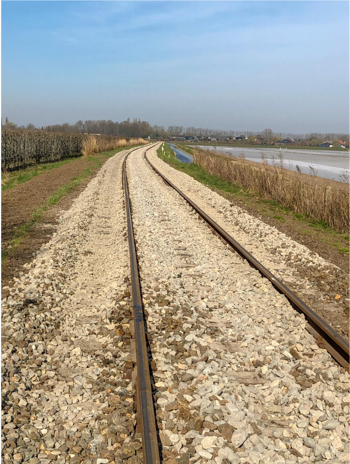
20 maart 2025: de nieuwe ballast is gestort op het vernieuwde spoor; nu nog vegen en profileren.
