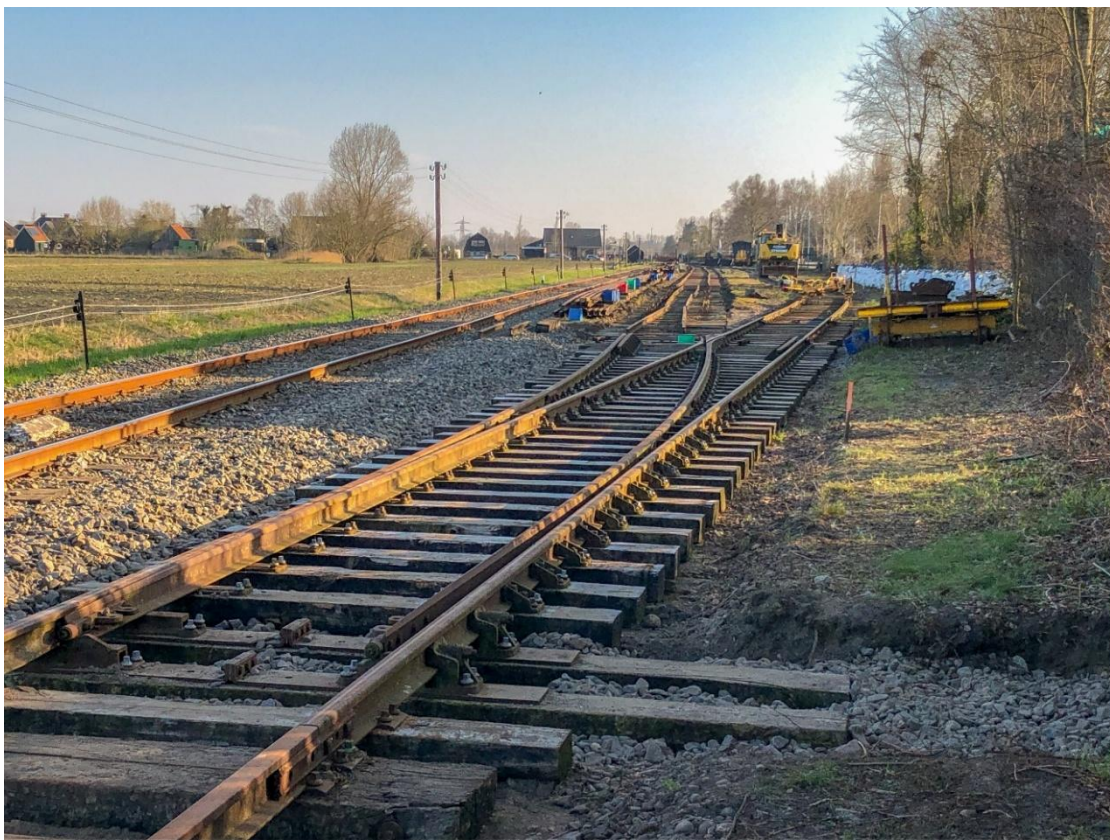
8 maart 2025: de zaterdagploeg heeft spoor 3 te Wognum d.m.v. wissel 5 aangesloten op spoor 2 en daarmee op de hoofdlijn.
