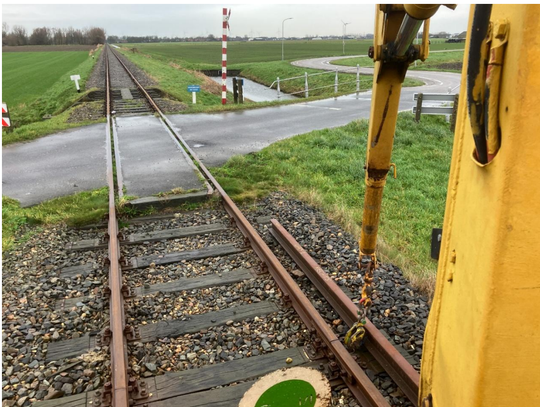
9 december 2025: spoorstaven laden op station Wognum, om ze vervolgens op diverse plekken langs de lijn neer te leggen. Tijdens de komende onderhoudsperiode zullen ze worden gebruikt om verslagen lassen te repareren.
