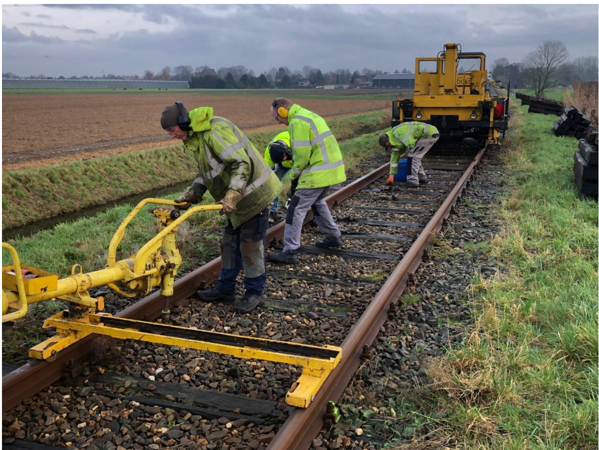
4 januari 2025: de spoorlijn tussen Zwaagdijk en Wognum wordt vernieuwd. Op deze foto's worden de spoorstaven losgemaakt van de dwarsliggers, die zullen worden vervangen door nieuwere exemplaren die rechts al klaar liggen.
