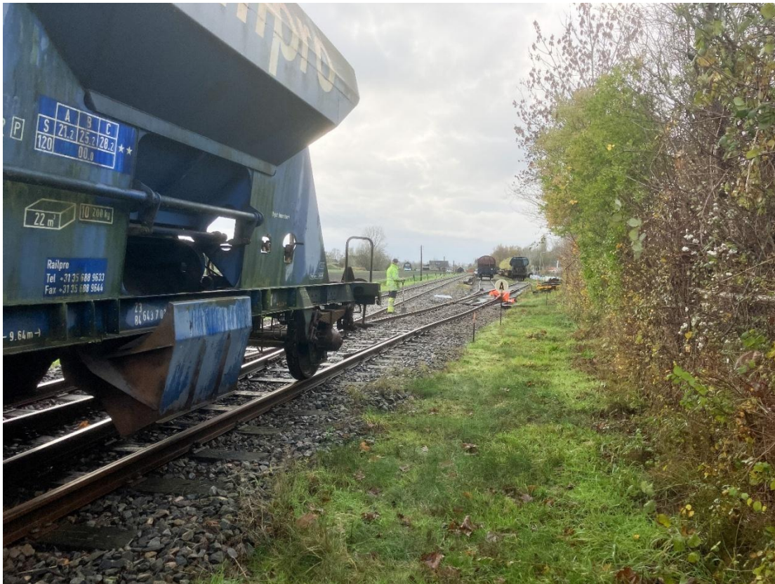
25 november 2025: een verzakking in spoor 2 te Wognum wordt verholpen door het spoor op te krikken en nieuwe ballast bij te storten.
