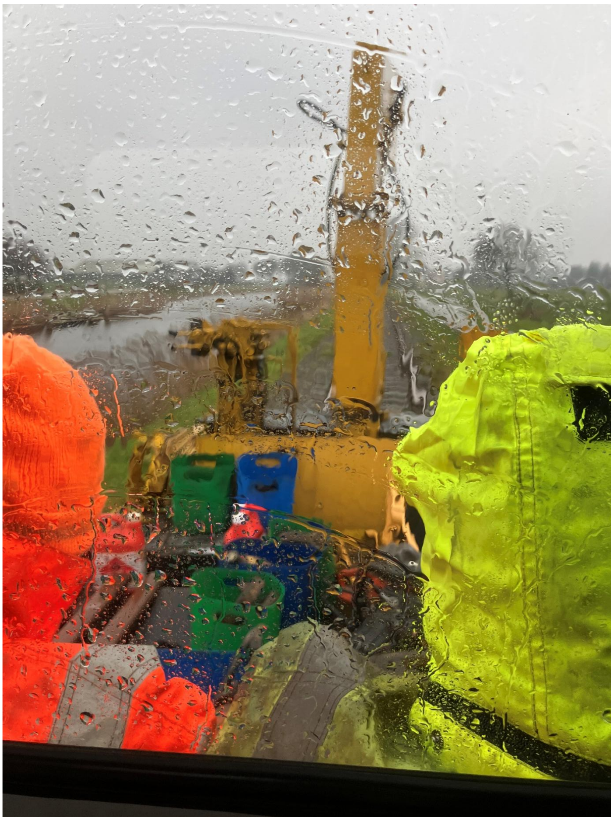
11 februari 2025: en hier zijn we met die spoorstaven op pad vanuit Wognum richting Twisk, om nog enkele plekken te bedienen waar herstelwerk aan raillessen verricht moet worden. Het weer was echter zó koud en nat dat ik daarvan geen foto's heb gemaakt ...
