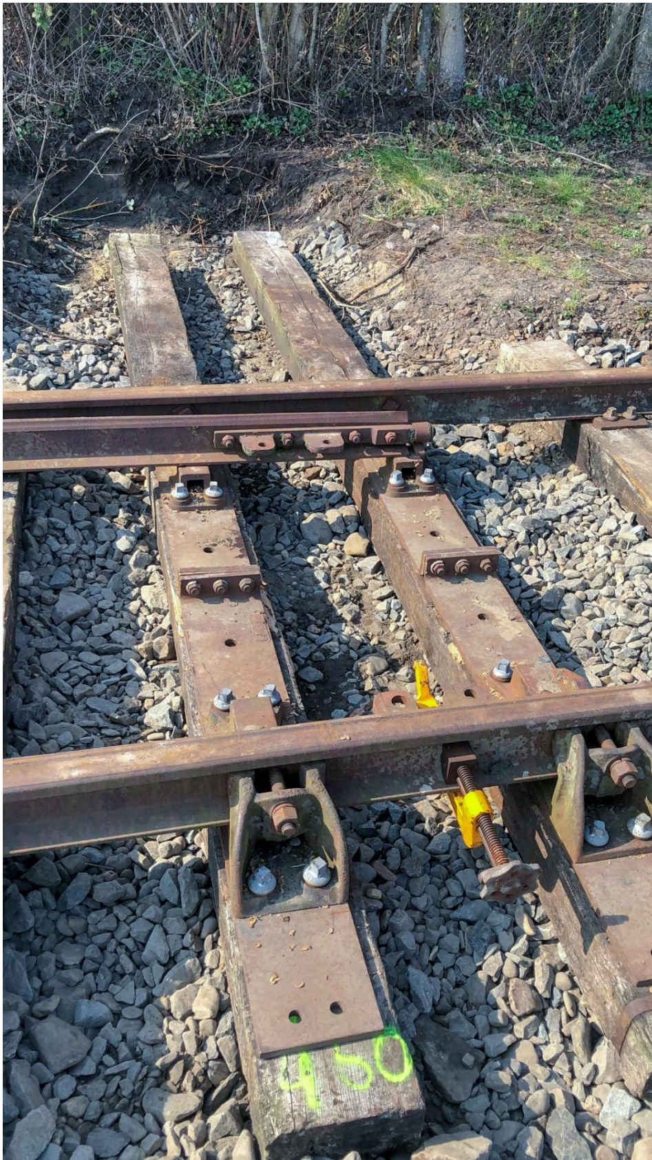
24 maart 2025: de lange wisselhouten waar de omzetstoel op zal worden gemonteerd; wissel 5.
