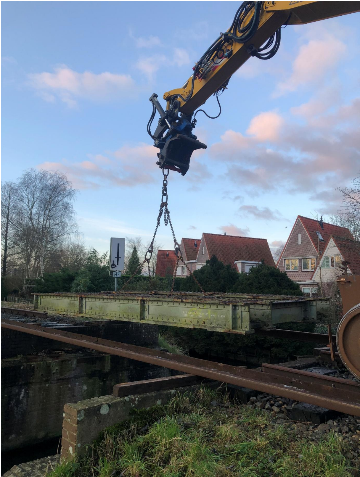
8 januari 2025: de brug over de Holensloot wordt uitgenomen om een grote onderhouds- en schilderbeurt te ondergaan.
