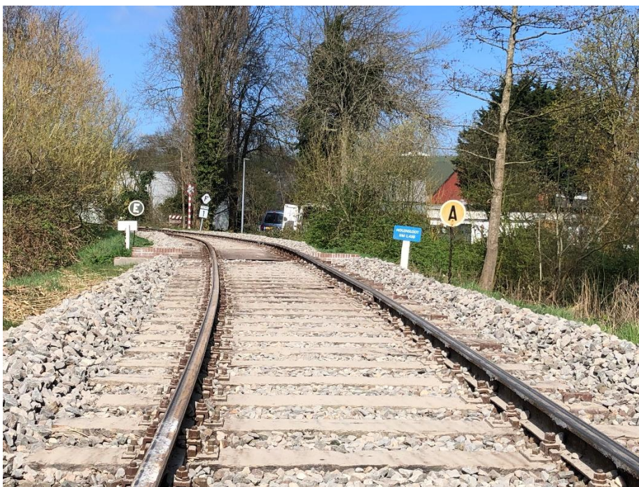
1 april 2025: ook de rails aan weerszijden van de brug over de Holensloot zijn gelicht, gestopt en afgewerkt. Alleen de anti-wip moet nog worden aangebracht; tot zolang blijft de snelheidsbeperking (het gele bord) van kracht.
