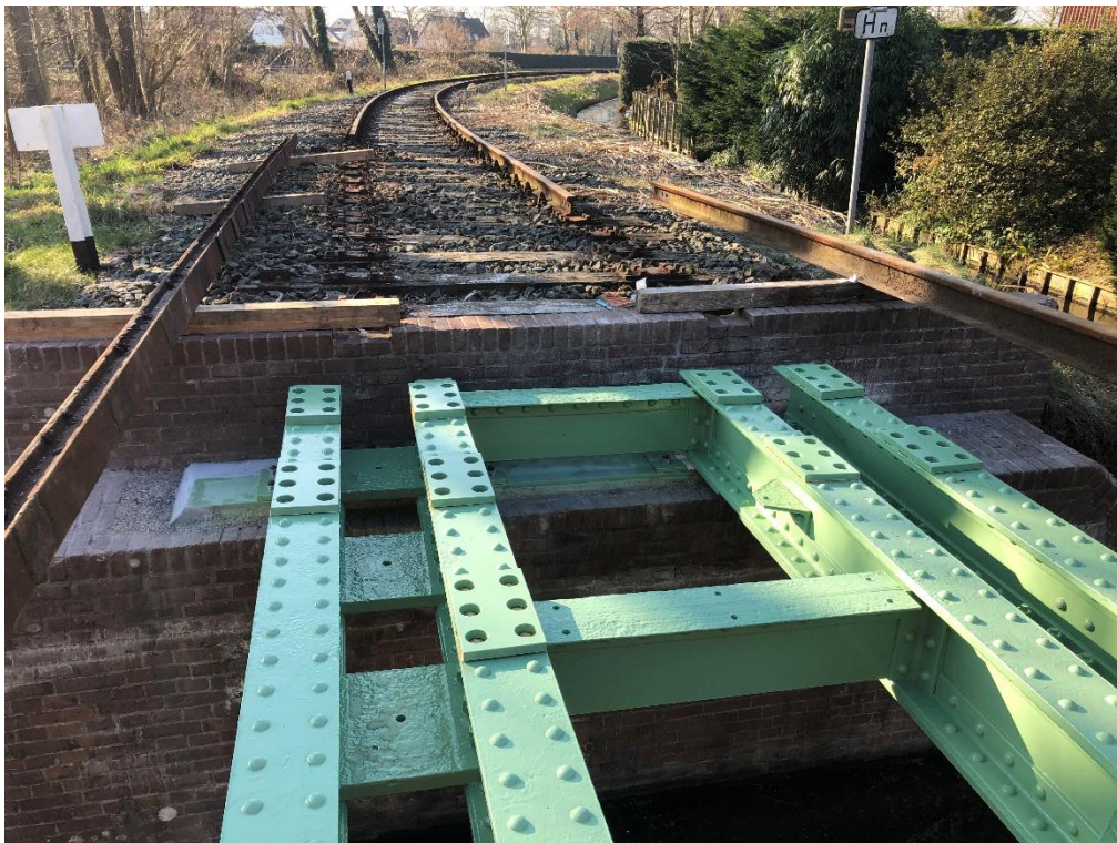
18 februari 2025: de brug over de Holensloot ligt weer op z'n plek.
