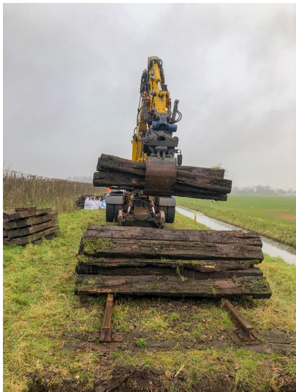
14 januari 2025: de oude dwarsliggers (of wat daarvan over is) worden afgevoerd.
