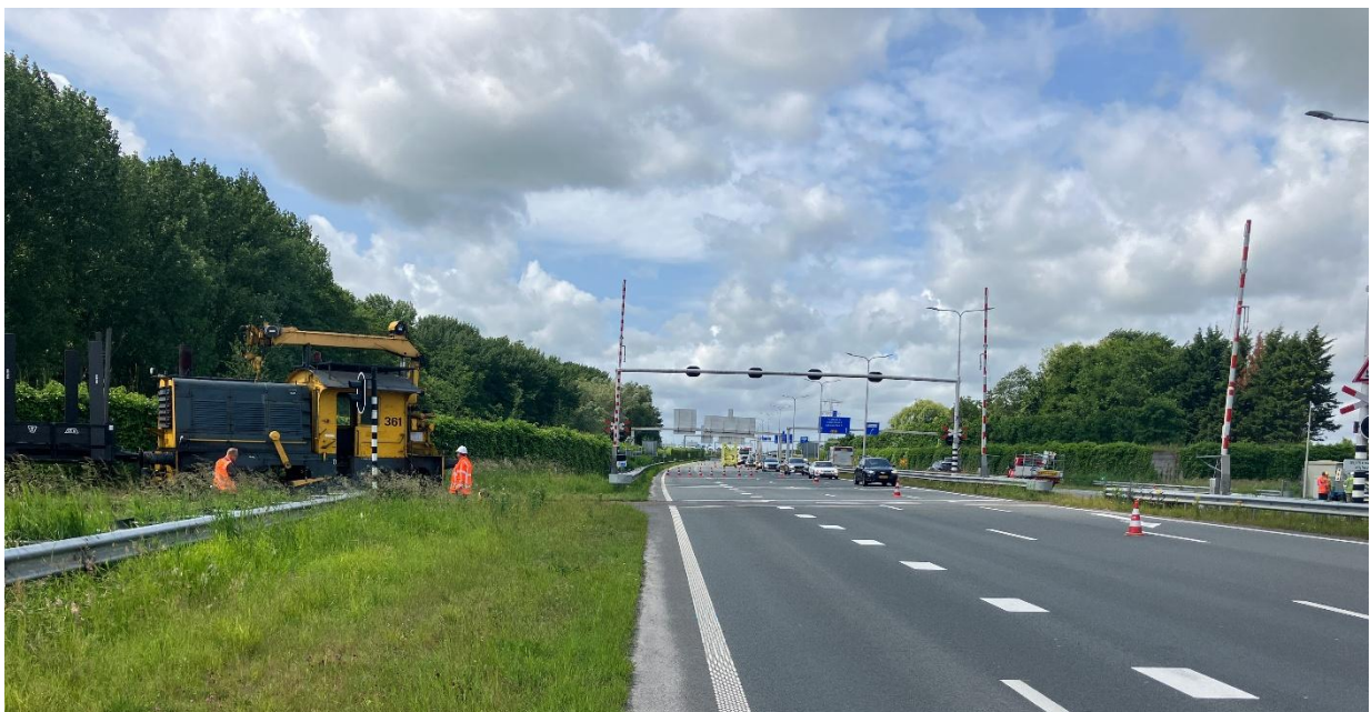
6 juni 2025: locomotor 361 heeft gereedschap en reserve-onderdelen aangevoerd ten behoeve van onderhoud aan de overweginstallatie Westfrisiaweg.
