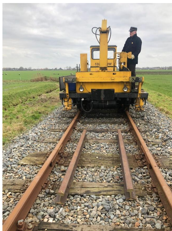
Ze werden neergelegd bij enkele lussen, waarvan de koppen teveel naar beneden zijn verbogen. Na deze – op 28 januari uit te voeren - reparatie zijn de spoorstaven dan weer keurig recht.
