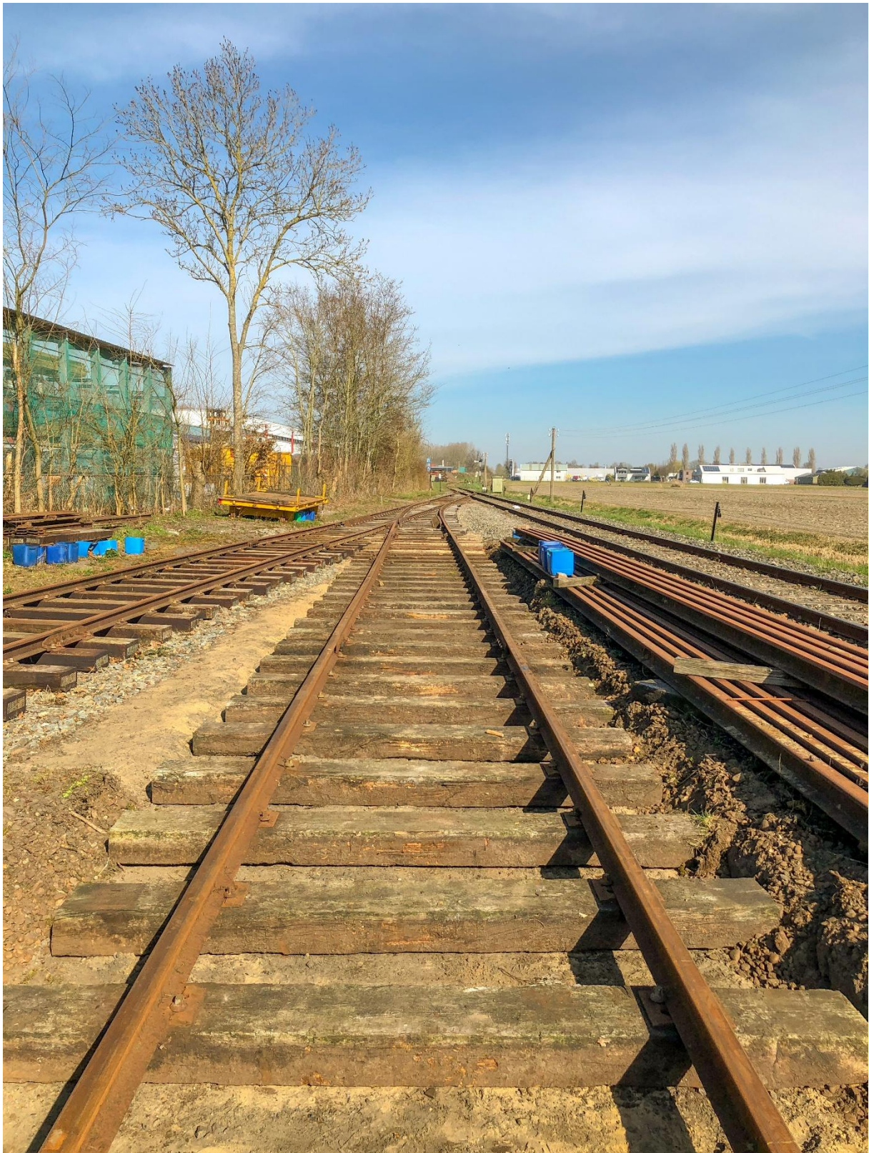
21 maart 2025: in Wognum is nu ook spoor 2 aangesloten op het nieuwe wissel nr. 5 naar spoor 3. De afwerking komt voor rekening van de zaterdagploeg.
