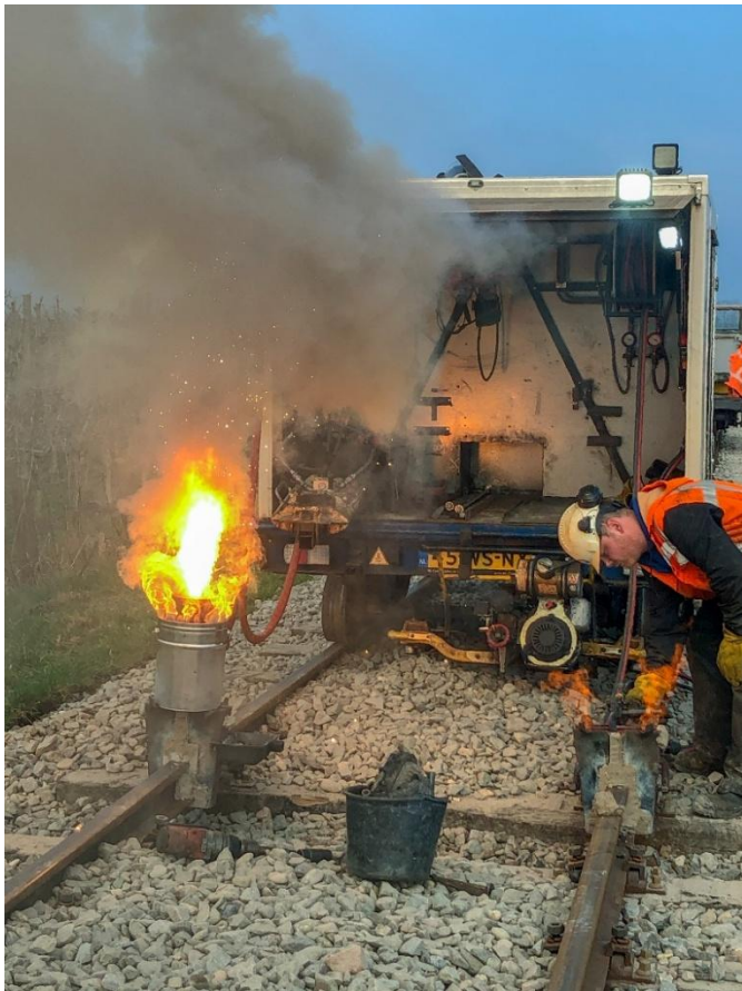
24 maart 2025: enkele raillassen tussen korte spoorstaven worden vervangen door thermietlassen; dat spaart onderhoudskosten in de toekomst.
