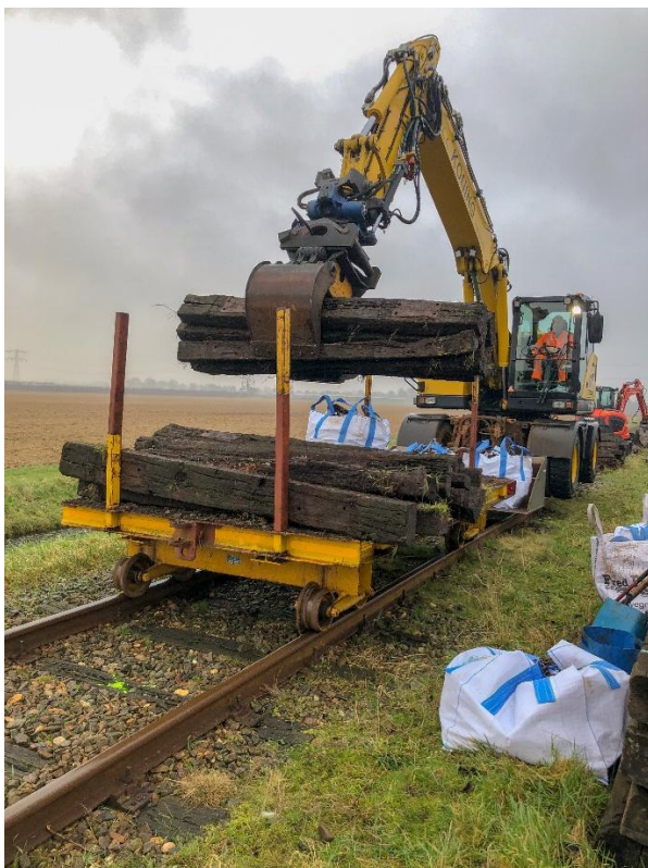
14 januari 2025: de oude dwarsliggers (of wat daarvan over is) worden afgevoerd.
