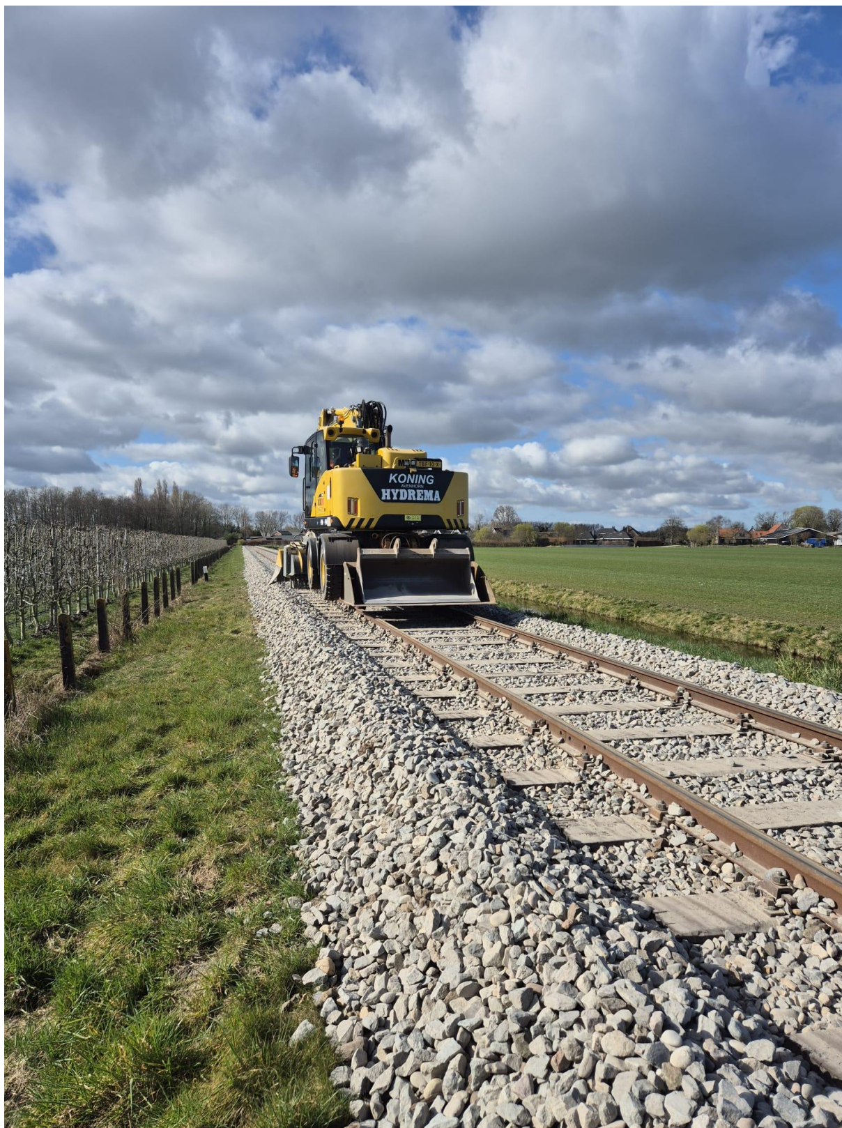
26 maart 2025: de nieuwe ballast in het spoorgedeelte tussen Zwaagdijk en Wognum wordt geveegd en geprofileerd.
