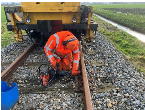
Ze werden neergelegd bij enkele lussen, waarvan de koppen teveel naar beneden zijn verbogen. Na deze – op 28 januari uit te voeren - reparatie zijn de spoorstaven dan weer keurig recht.
