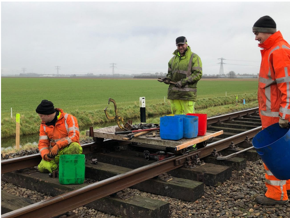
6 februari 2025: de ploeg die het kleine ijzerwerk aanbrengt heeft km. 5,7 bereikt. Nog 290 meter !
