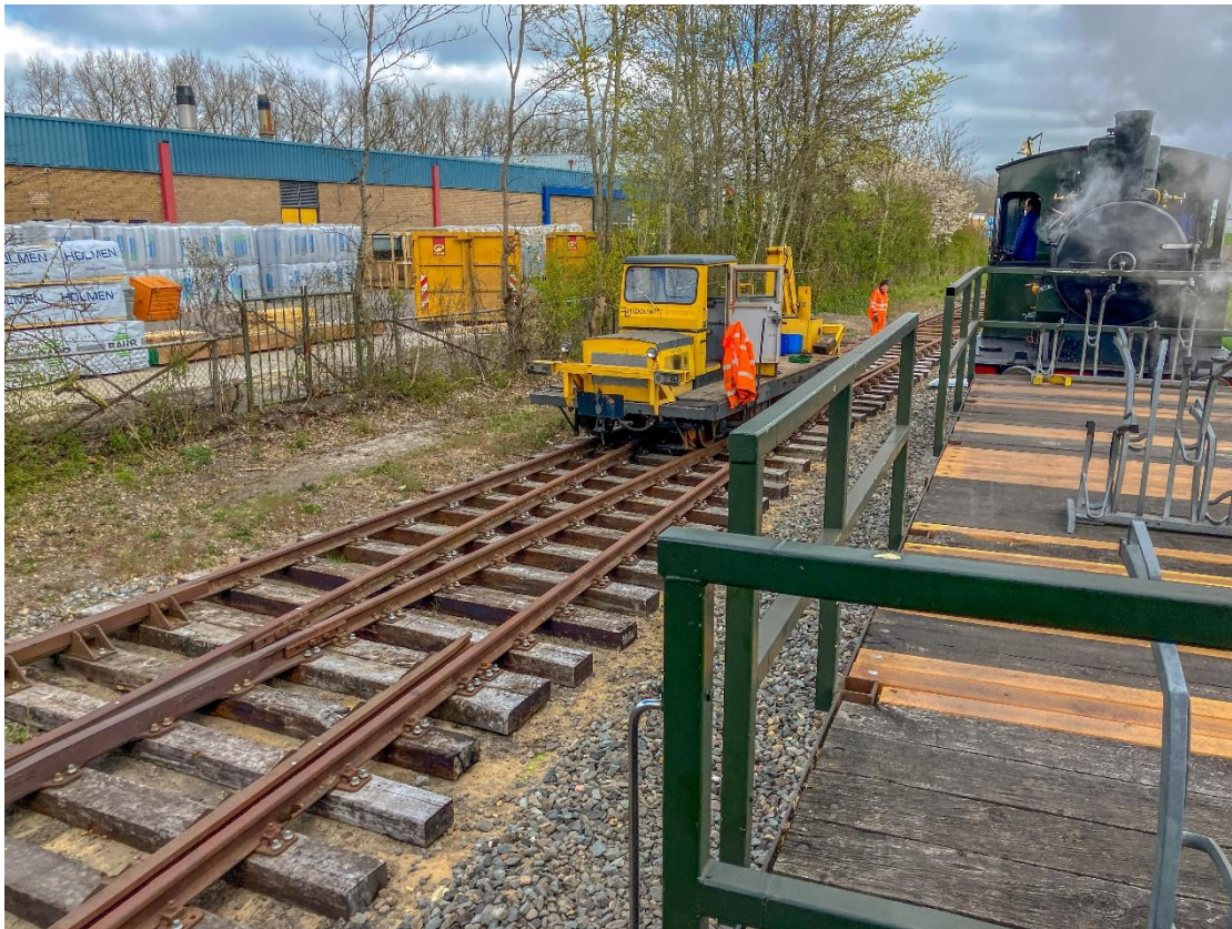
10 april 2025: de noeste werkers aan de nieuwe sporen 2 en 3 te Wognum pauzeren even, om de boottram van 10.40u te laten passeren.
