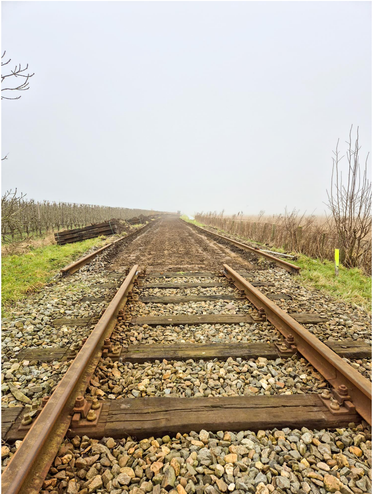
21 januari 2025: na het verwijderen van de oude dwarsliggers wordt het ballastbed gevlakt, ...
