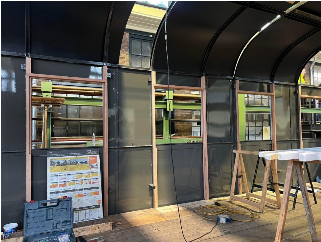
In rijtuig 59 wordt een nieuw raamwerk getimmerd, waarop straks de binnenbetimmering wordt aangebracht.
