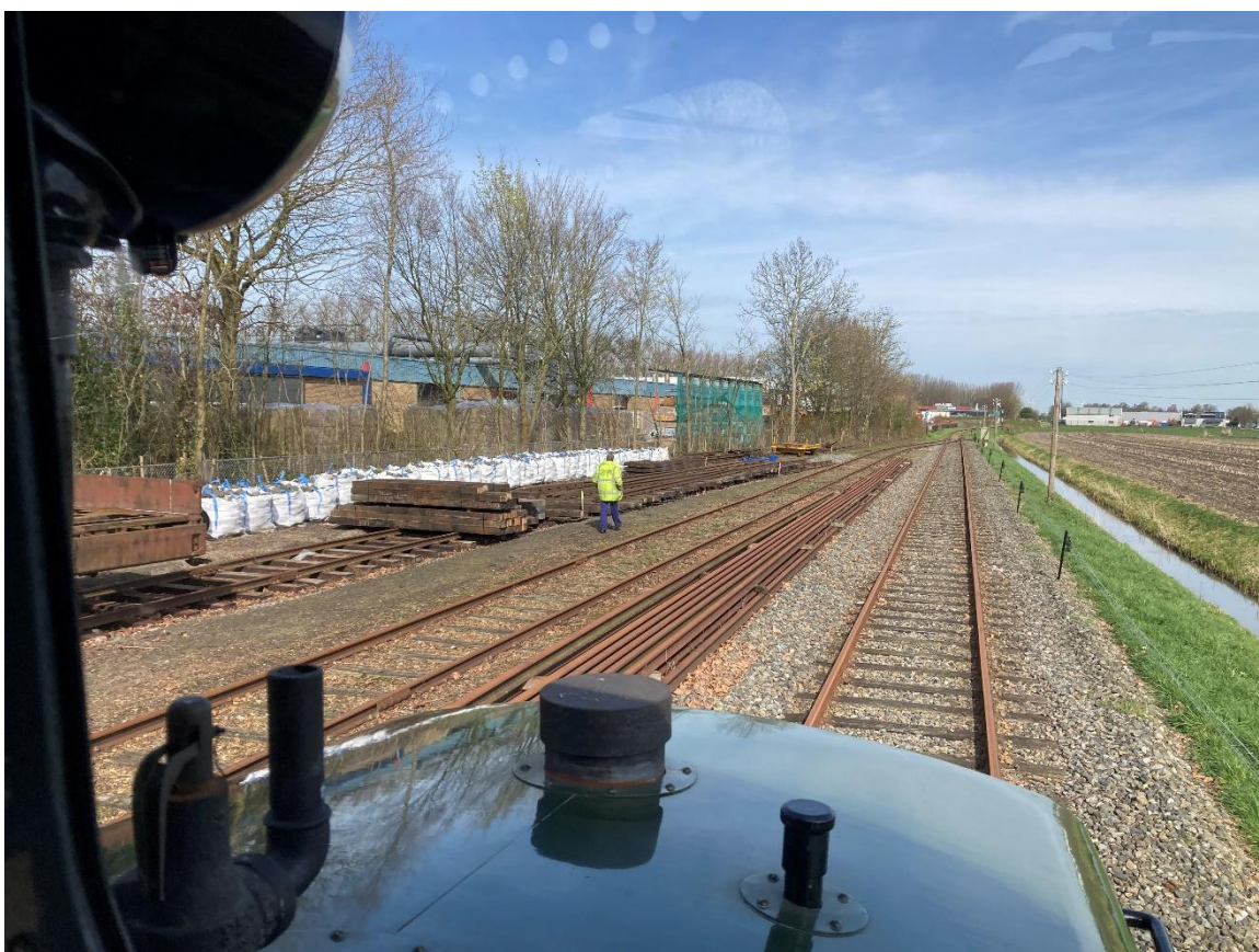
In Wognum worden de werkzaamheden aan spoor 3 weer voortgezet.
