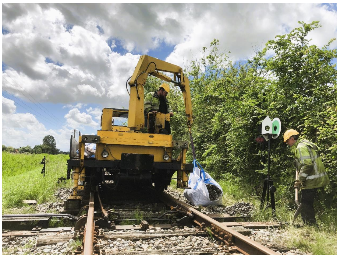
15 juni 2024: wissel 2 te Wognum wordt, na vervanging van enkele dwarsliggers, onderstopt met extra ballast.
