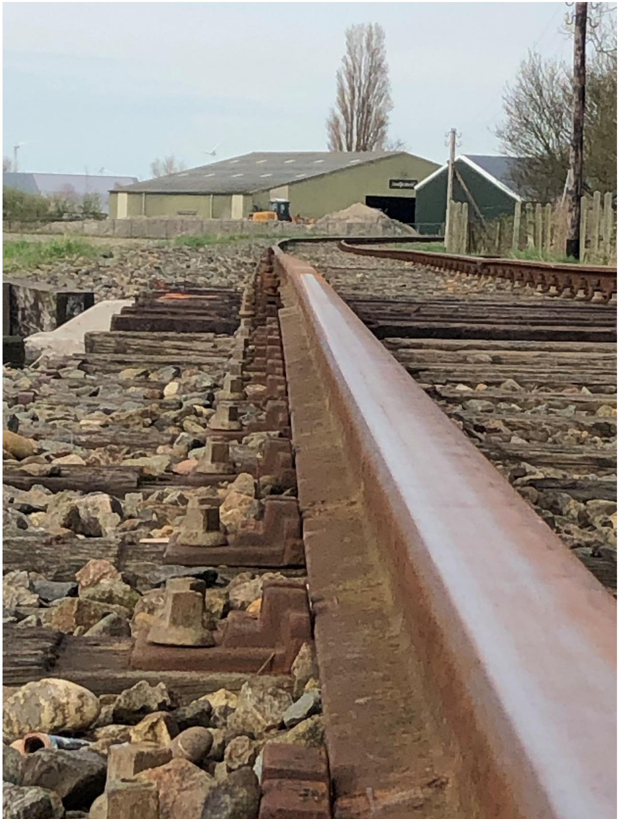
16 maart 2024: nu nog de nodige klembouten en dan kan de stop- schiftmachine de laatste oneffenheden wegwerken.
