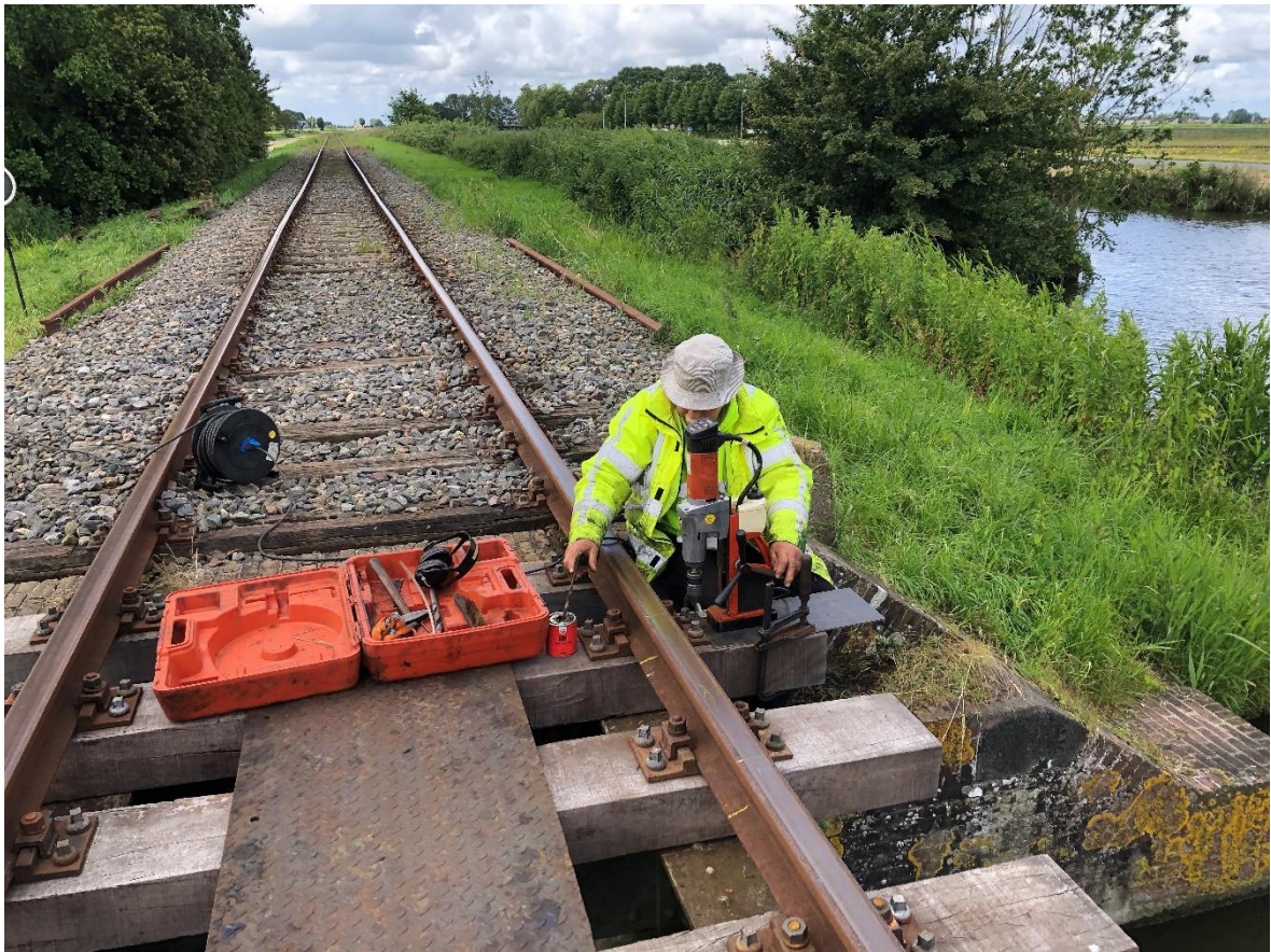
nieuwe gaten boren voor de antiwip,
