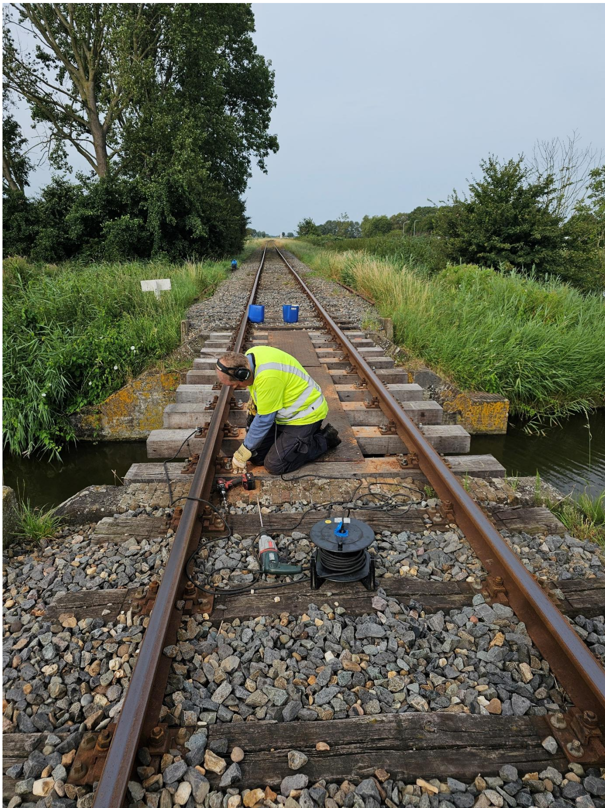
1 augustus 2024: Roelof van der Molen bereidt de brug nabij station Oostwoud voor om de verstevigings-spoorstaven weer terug te kunnen leggen. (Foto Floris Rosenbrand)
