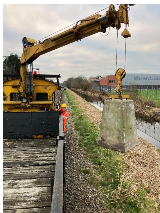
11 december 2024; kruising van twee werktreinen te Oostwoud (links) en nabij de overweg Liornestraat te Hoorn wordt het funderingsblok gelost voor het nieuwe inrijsein van Hoorn Tramstation.
