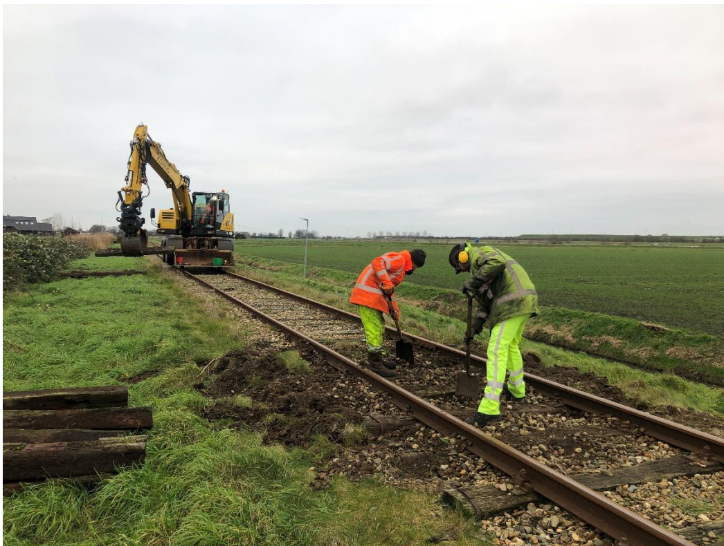
10 december 2024: de tijd van baanonderhoud breekt weer aan. Bij temperaturen net boven het vriespunt worden dwarsliggers vervangen door nieuwere exemplaren.
