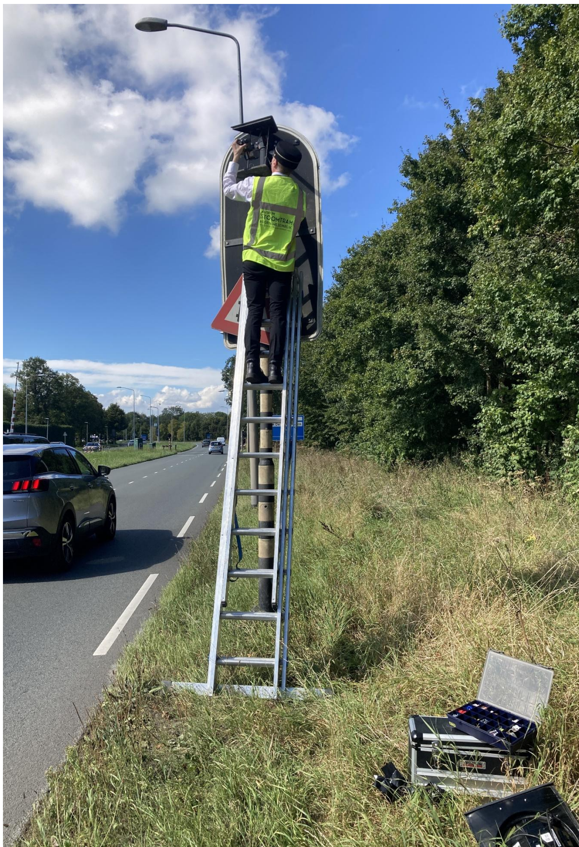
8 september 2024: tot het takenpakket van (niet elke) treindienstleider en depotmachinist behoort ook het uitrukken naar overweginstallaties die beschadigd worden door passerende vrachtauto's. Hier zijn zij doende nabij de halte Westerblokker.
