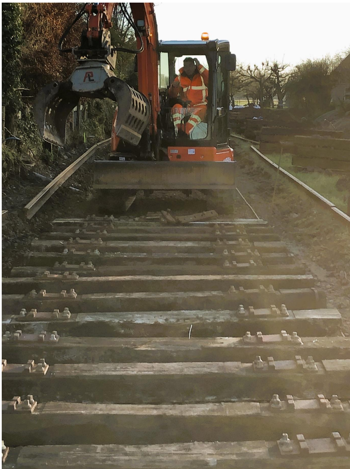
9 januari 2024: bij station Benningbroek-Sijbecarspel wordt ca. 150 m spoor vernieuwd.
