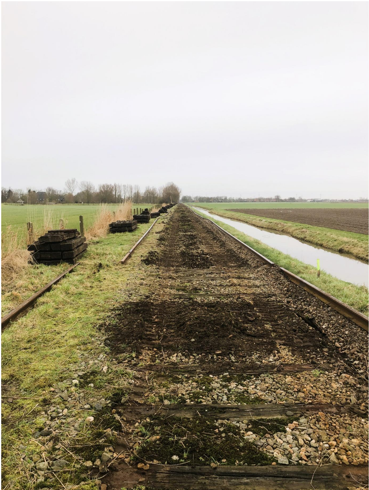
8 februari 2024: overzicht van de spoorvernieuwing, kijkend naar het noorden richting Twisk. Oude dwarsliggers worden verwijderd, en na schonen en vlakken van het ballastbed zullen de nieuwe worden neergelegd.
