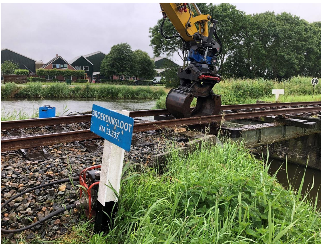
10 juni 2024: in de stromende regen werden de oude dwarsliggers op de brug vervangen.
