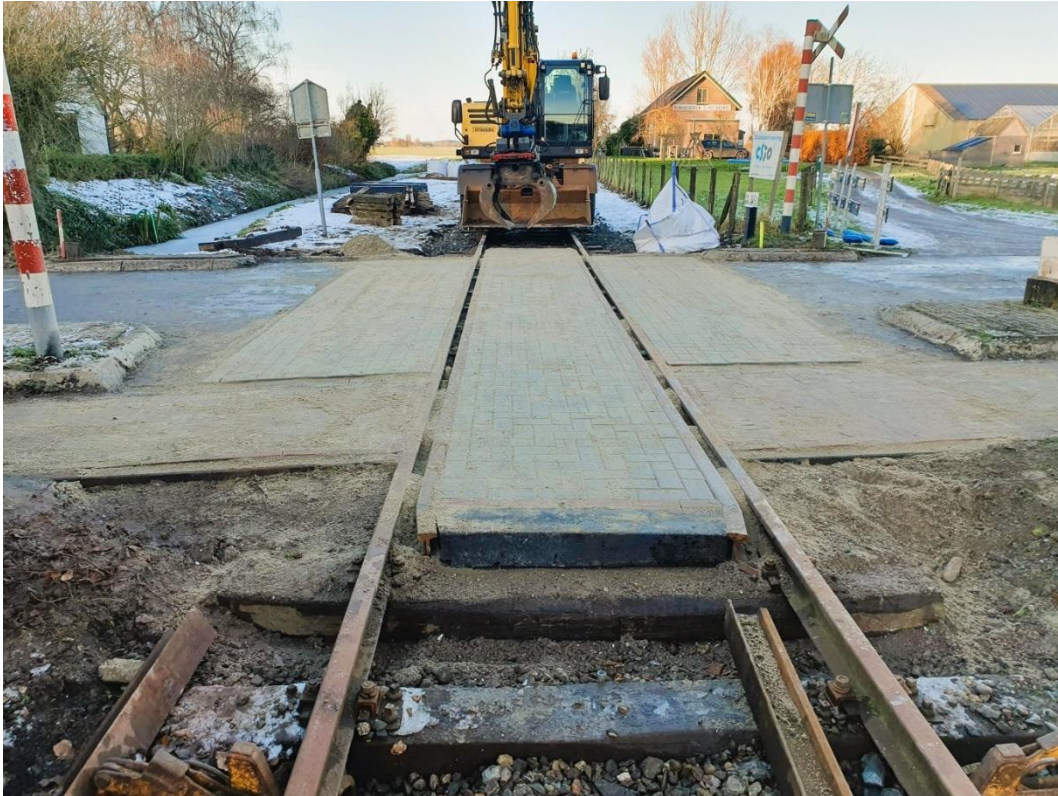
18 januari 2024: de vernieuwde overweg in de Oosterstraat te Benningbroek.
