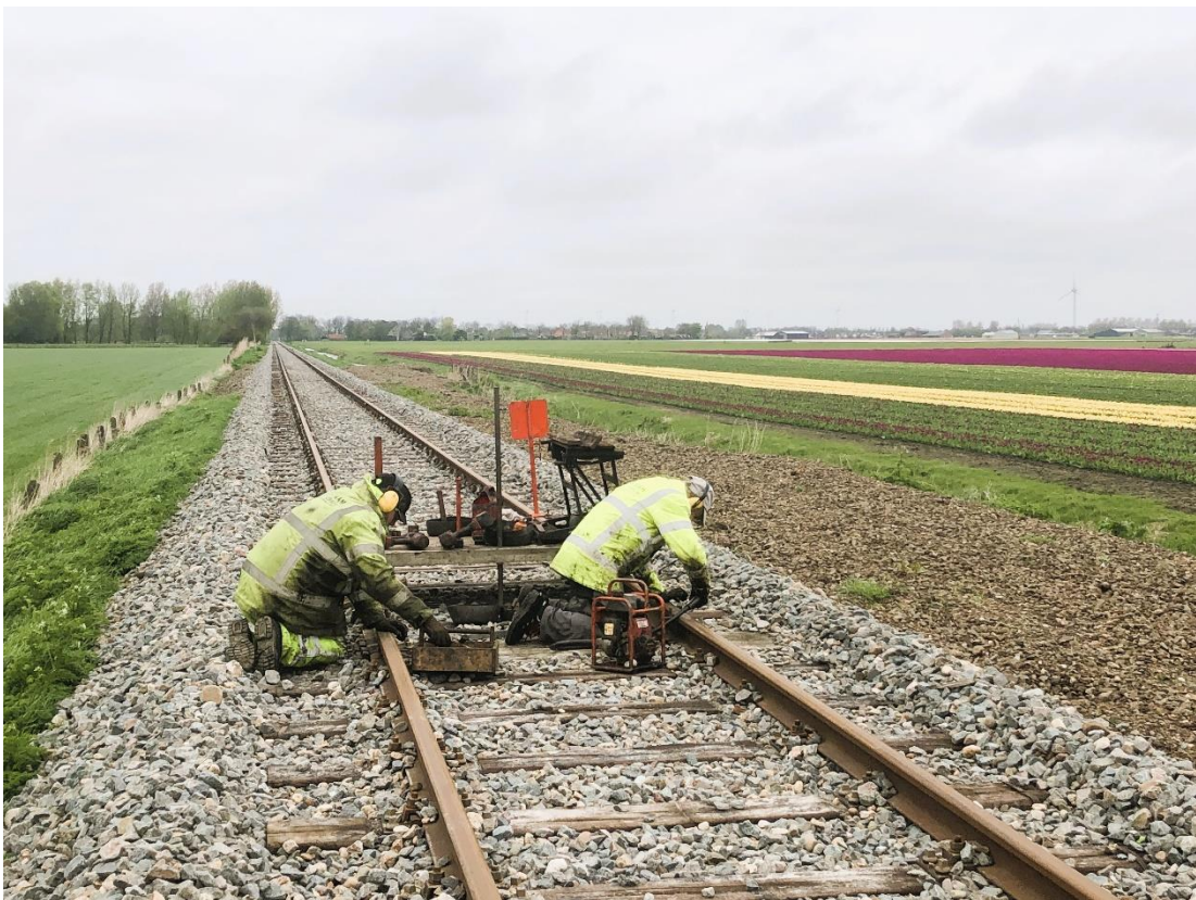
11 april 2024: het is voorjaar, de tulpen bloeien, en van het nieuw gelegde spoor worden de lasplaten losgenomen, ingevet en weer vastgezet.
