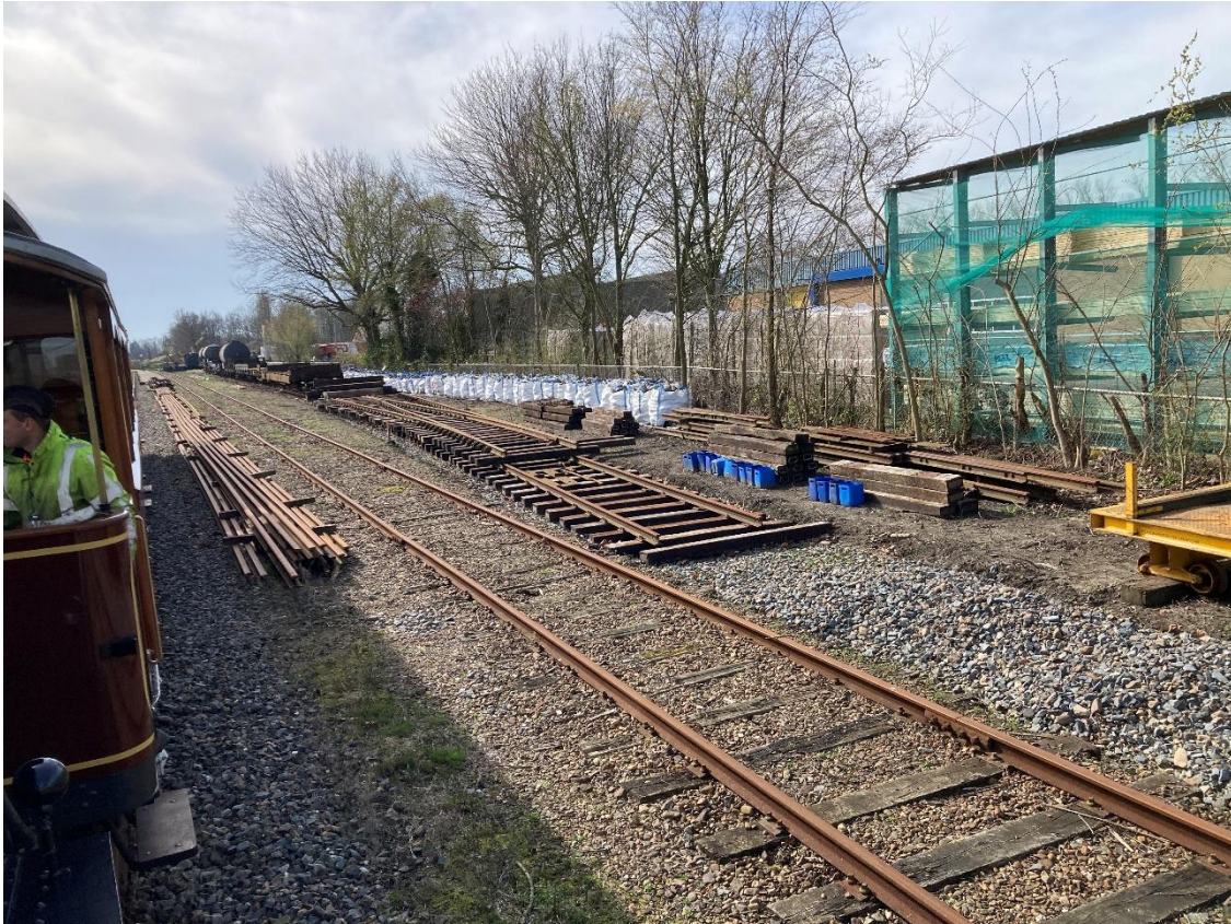
Het nieuwe wissel tussen spoor 2 en 3 ligt klaar om ingepast te worden.
