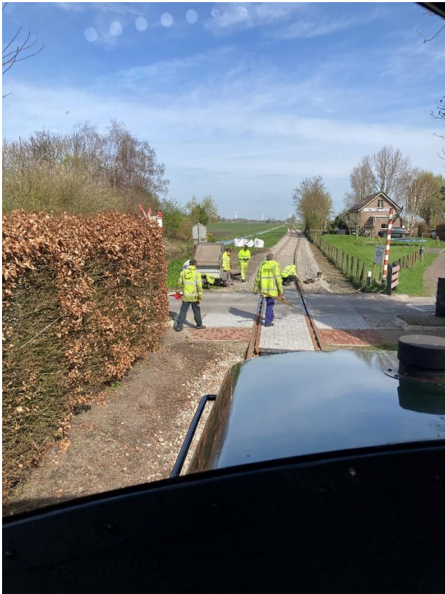
In Benningbroek wordt nog gewerkt aan de laatste loodjes van het nieuw gelegde stuk spoor.
