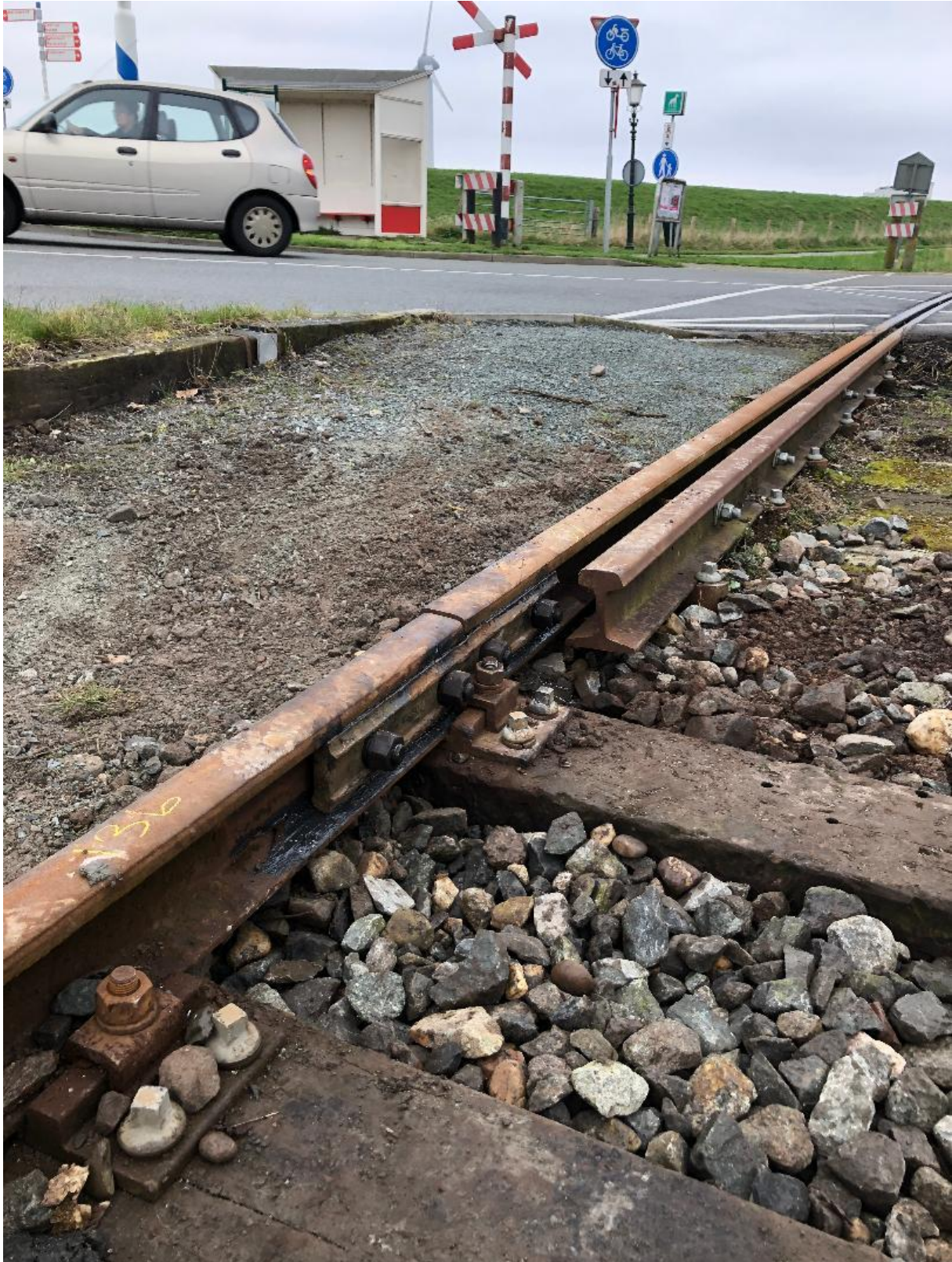
12 maart 2024: nabij station Medemblik werd nog een las tussen twee spoorstaven op de juiste wijze vastgezet door middel van verloop-lasplaten.
