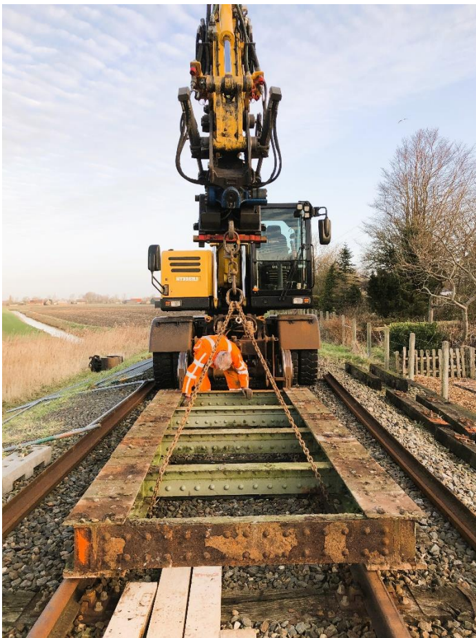
23 januari 2024: de brug over de Zwetsloot nabij Opperdoes werd van z'n plek gehesen.
