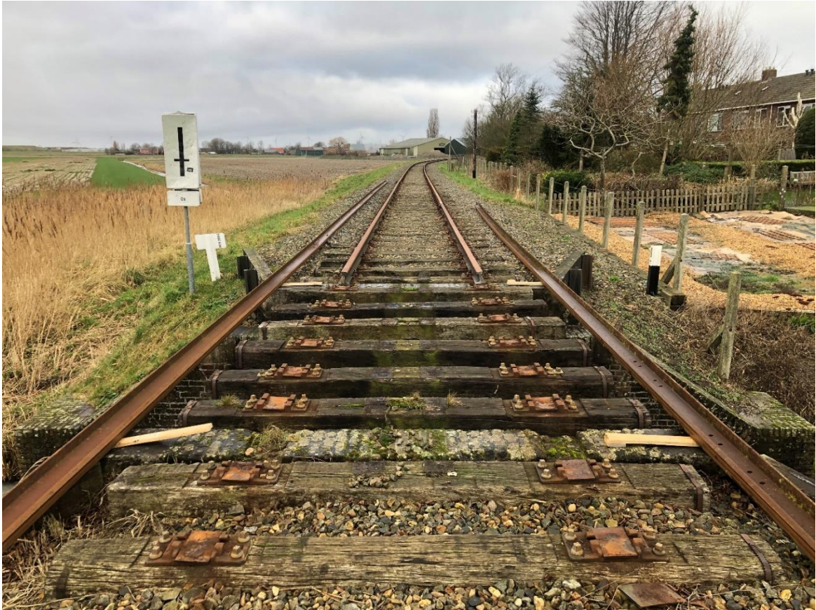
12 januari 2024: nabij Opperdoes is de brug over de Zwetsloot gereed gemaakt om te worden uitgehesen. De brug zal geheel gestraald, gerepareerd en geschilderd worden.
