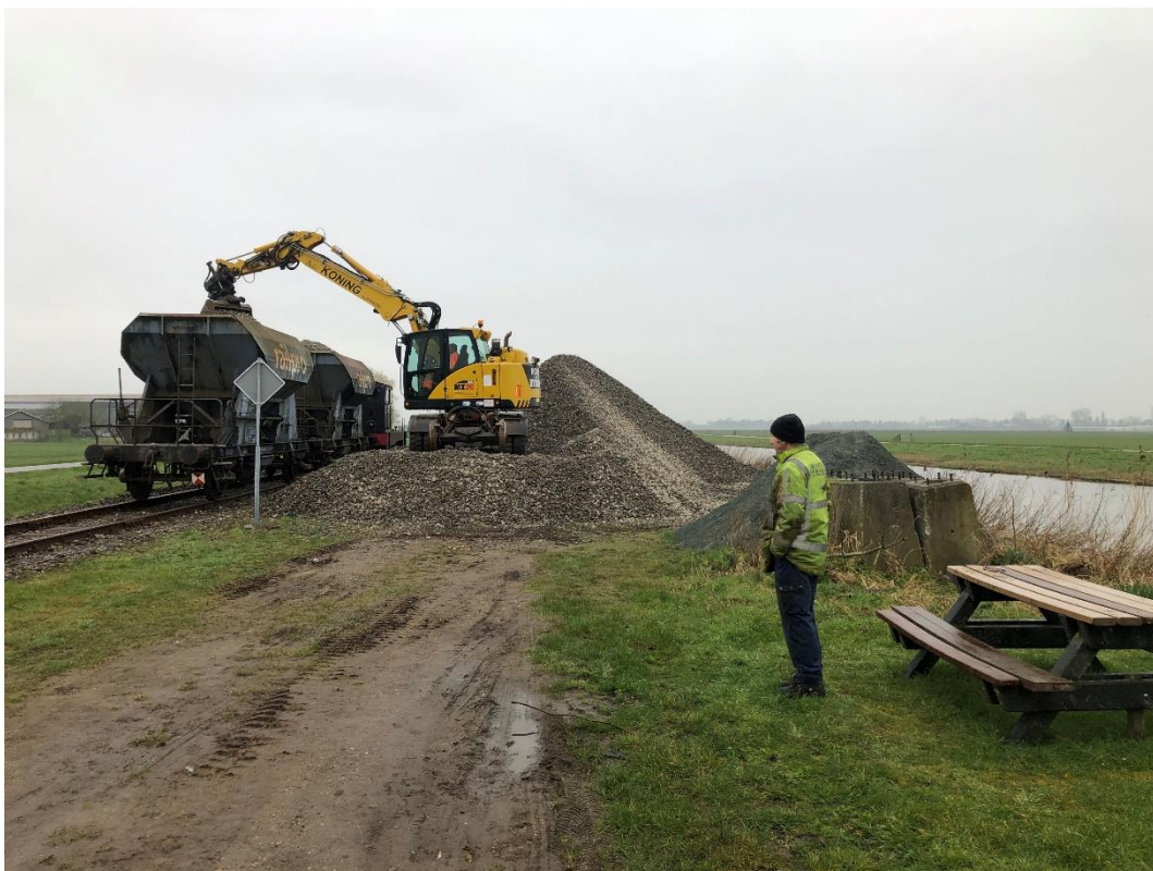
12 maart 2024: langs de Broerdijk opgeslagen ballast wordt in onderlossers geladen om naar het nieuw gelegde spoor te worden overgebracht.
