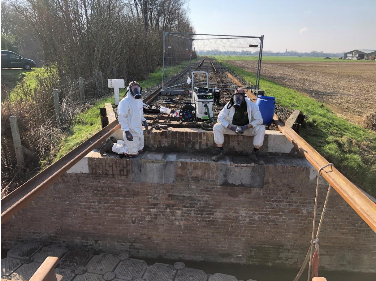
8 maart 2024: de landhoofden van de brug over de Zwetsloot worden hersteld.
