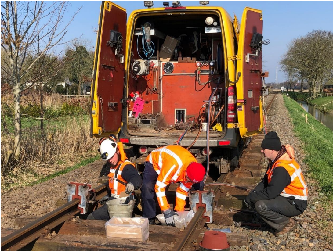
8 maart 2024: op meerdere plaatsen langs de lijn worden d.m.v. thermietlassen twee spoorstaven tot één geheel gemaakt.
