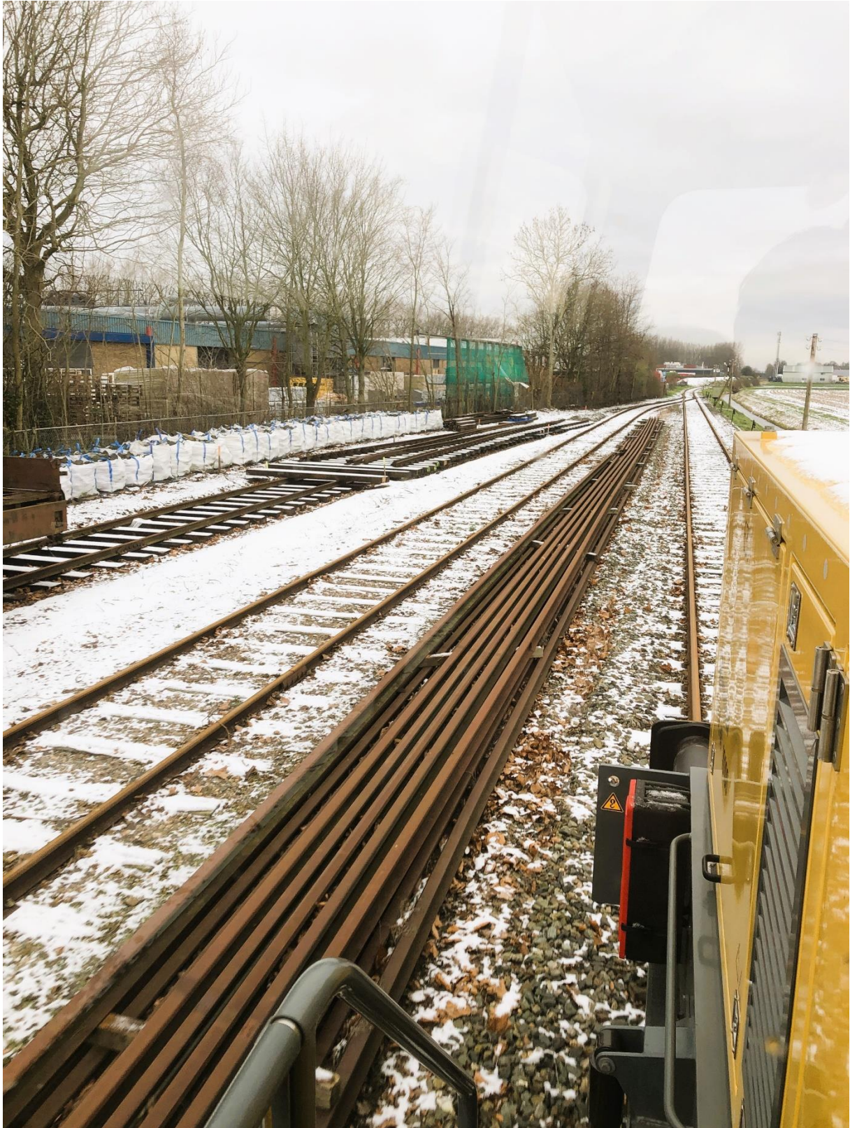
17 januari 2024: in verband met de omvangrijke werkzaamheden elders langs de lijn is het werk aan de verlenging van spoor 3 te Wognum even op een laag pitje gezet.
