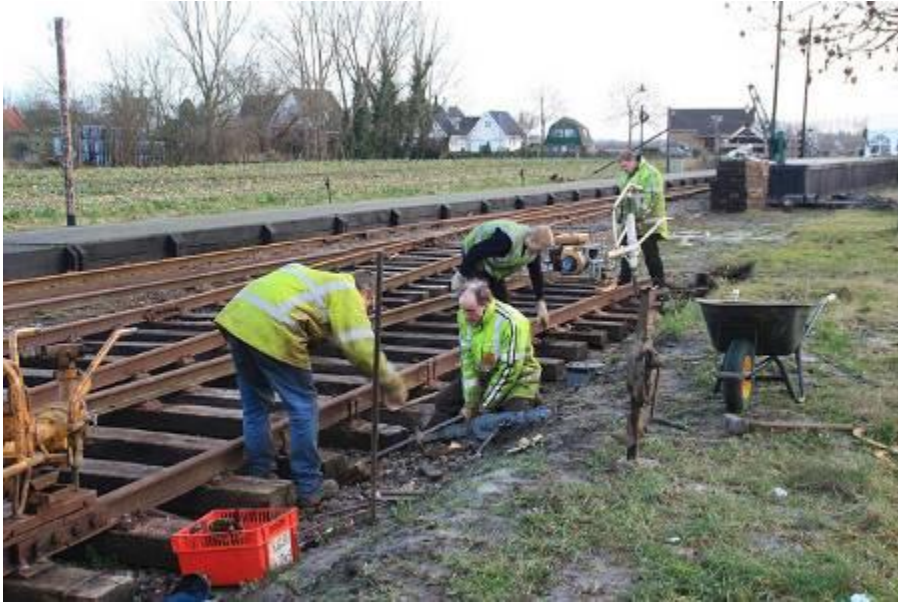
24 december 2011: aanleg spoor 3 Wognum.
