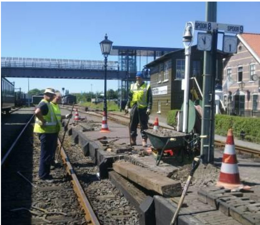
24 juli 2012: herstel perronwand Hoorn.
