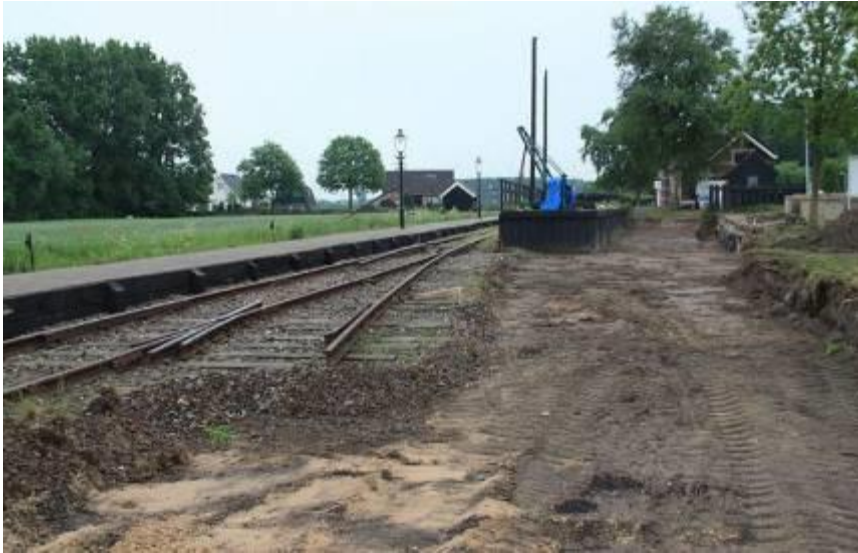
20 mei 2011: de aanleg van het nieuwe zijspoor 3 in Wognum.
