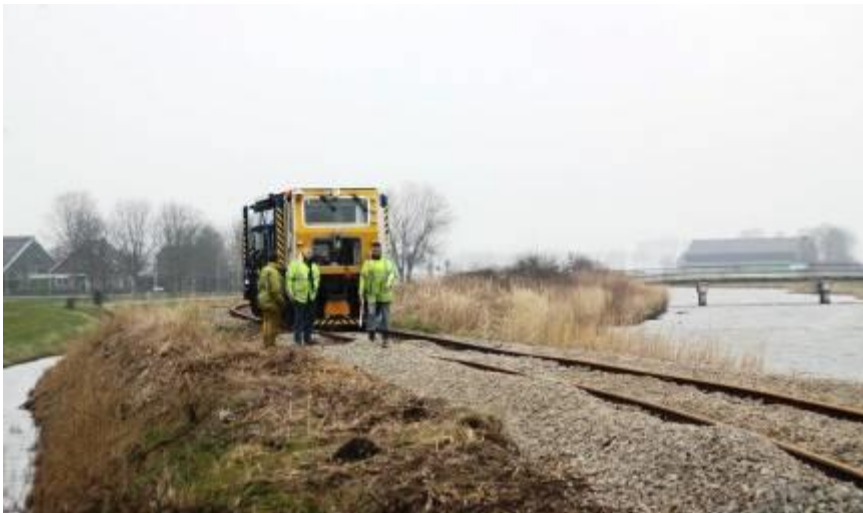
16 maart 2011: het vernieuwde spoor langs de Broerdijk wordt onderstopt.
