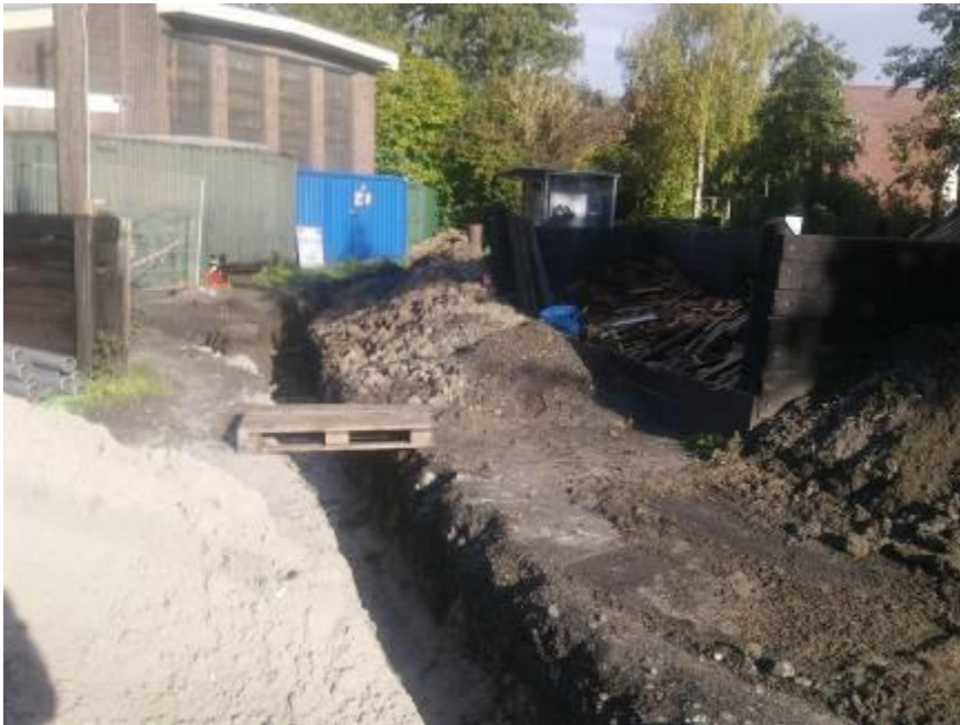
13 oktober 2011: aanleg van een nieuwe gasleiding naar de werkplaats Hoorn
