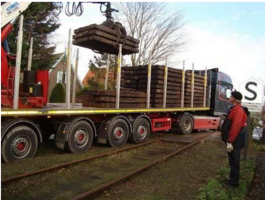
13 december 2011: nieuwe dwarsliggers worden gelost t.b.v. de spoorvernieuwing nabij Opperdoes.
