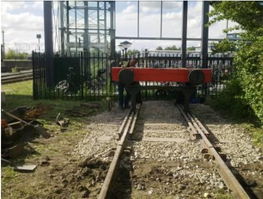
13 september 2012: plaatsing stootjuk spoor U in Hoorn
